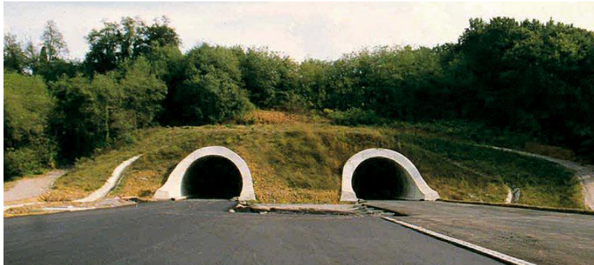
Figura 2-18. Restitución mediante relleno de la pendiente natural de la ladera del portal de los túneles de Malenchini, Italia. Fuente: Lunardi, 2008
