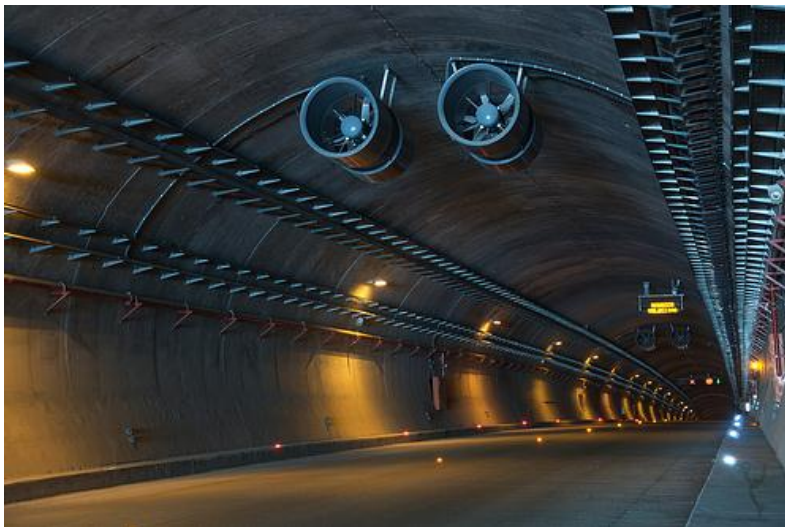
Figura 4-3. Túnel El Sinaloense, Carretera Durango-Mazatlan. Fuente: Torres, 2013
