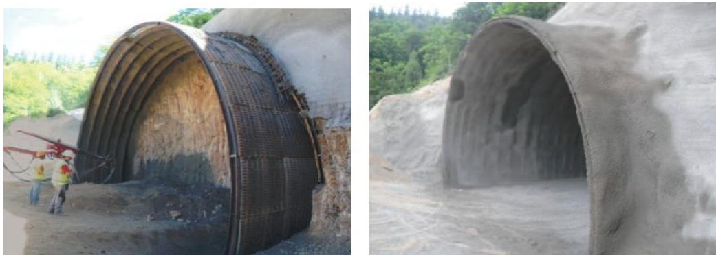
Figura 3-3. Ejecución de túnel falso provisional. Fuente: MTC, 2014
