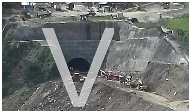
Figura 1-4. Portal en “V” o encajonado. Fuente: INVÍAS, 2015
