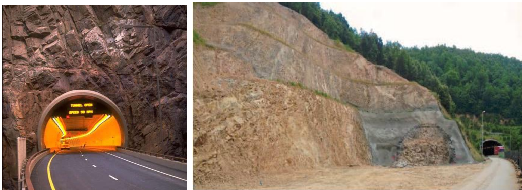
Figura 2-12. Izquierda: Túnel Glenwood Canyon, Colorado. Fuente: Hung et al, 2009. Derecha: Encaje de portal a media ladera. Fuente: MTC de Perú, 2014
