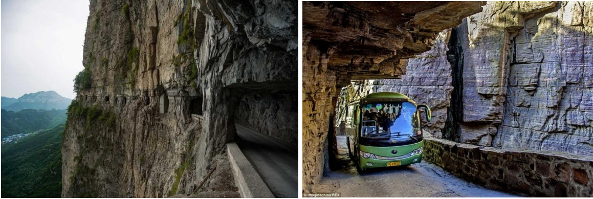
Figura 4-30. Izquierda: Pilares del Túnel Gouliang. Fuente: Cookie Sound, 2014. Derecha: Túnel Gouliang en voladizo. Fuente: Daily Mail, 2014
