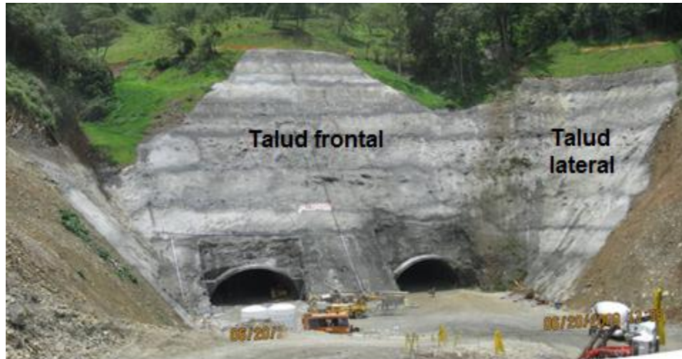
Figura 1-2. Taludes de un portal. Fuente: Gutiérrez, 2010
