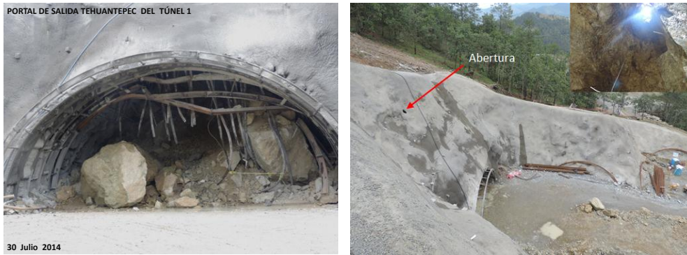
Figura 2-3. Aspecto general del portal Tehuantepec del túnel Cerro de Apazcle. Fuente: Consultec, 2014
