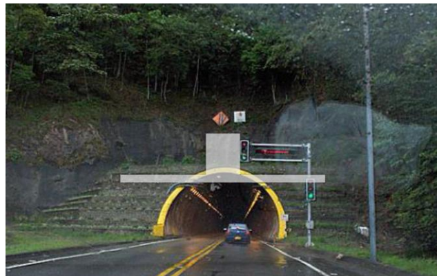
Figura 1-7. Portal en “T” o perpendicular. Fuente: INVIAS, 2015
