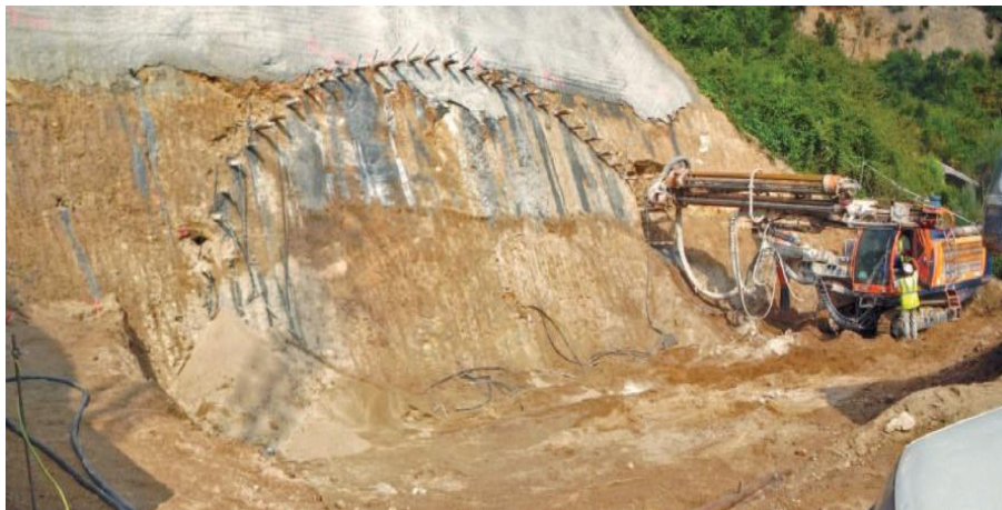
Figura 3-7. Paraguas de micropilotes. Fuente: MTC, 2014
