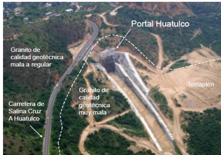
Figura 2-13. Túnel Salina Cruz, Oaxaca, México. Portal Huatulco que presenta baja calidad del terreno. Fuente: Suárez F., 2012
