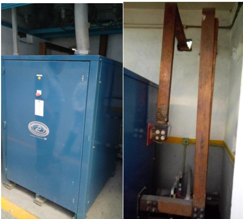
Ilustración 24 Rectificadores de corriente y electrodos de cobre
