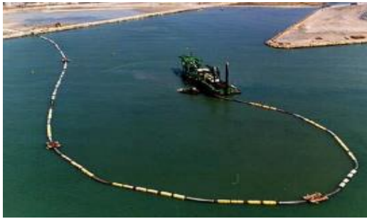
Ilustración 4-3, Transporte y descarga por tuberías. (Marine Service Mediterranean, 1993).
