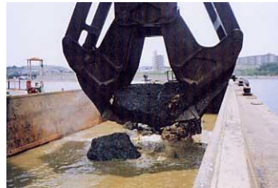
Ilustración 5-7 , Draga de cuchara, removiendo piedras en el canal de Tunkey
