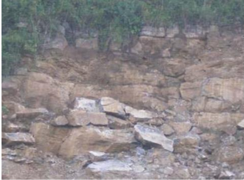
Fig. 4.18. Bloques inestables en la parte alta de la escarpa de falla (Fuente: CENAPRED)
