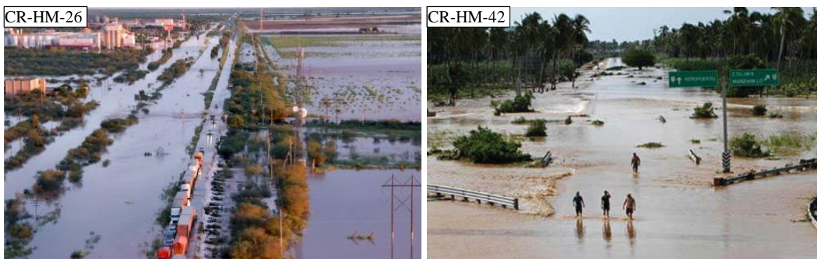
Fig. 4.27. Daños por inundación pluvial.
