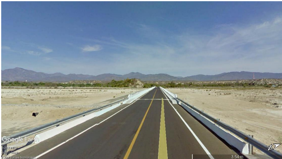
Fig. 3.4. Vista a nivel de terreno “Street View” (Fuente: Google Street View 2017)
