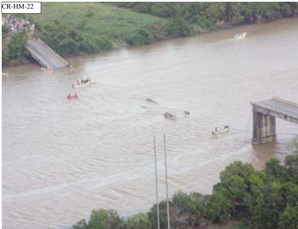
Fig. 4.10. Colapso del puente Tonalá
