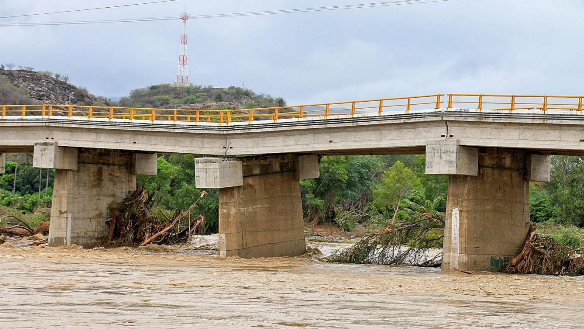
Fig. 4.11. Daños en puente Tequisistlán, Oaxaca por corriente de agua. Fuente: nvinoticias.com
