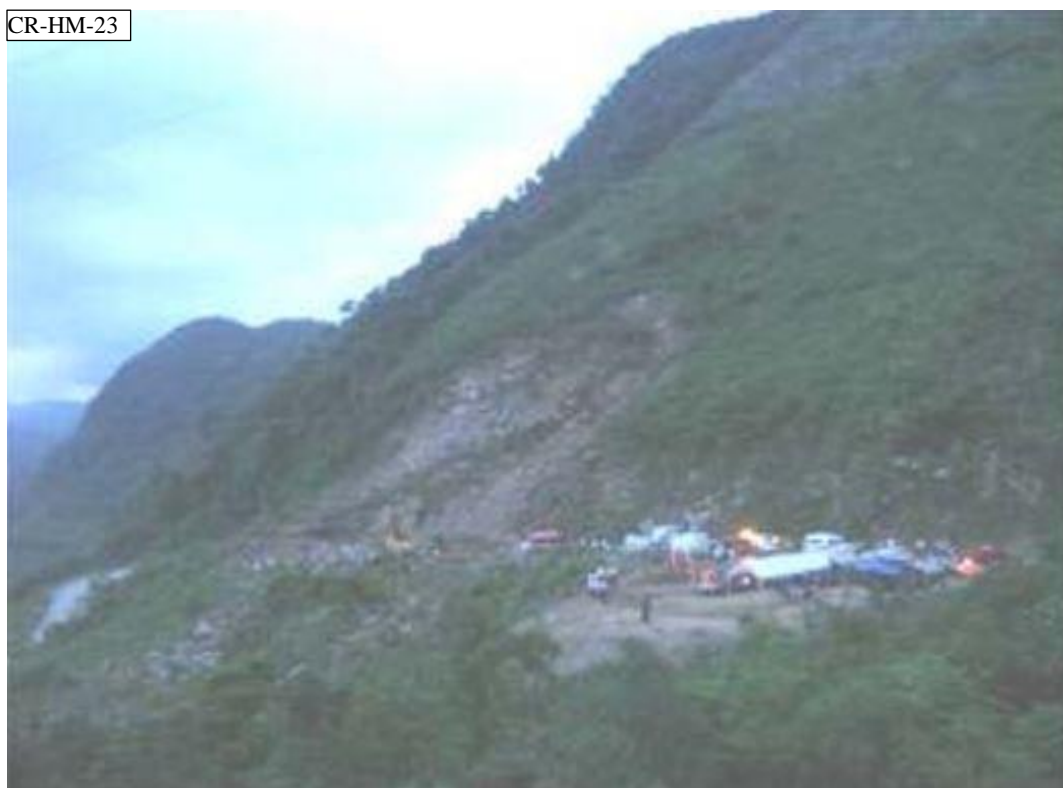
Fig. 4.17. Deslave de ladera sobre la carretera Tepeyac – Tlacotepec de Díaz (Fuente: CENAPRED)
