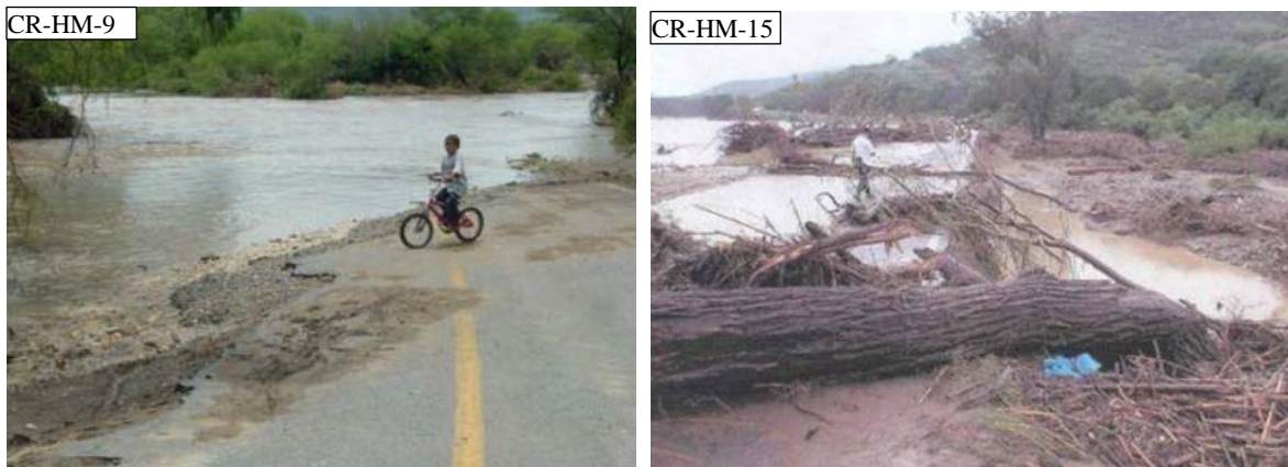
Fig. 4.26. Daños por seccionamiento y azolve generados por inundación fluvial.
