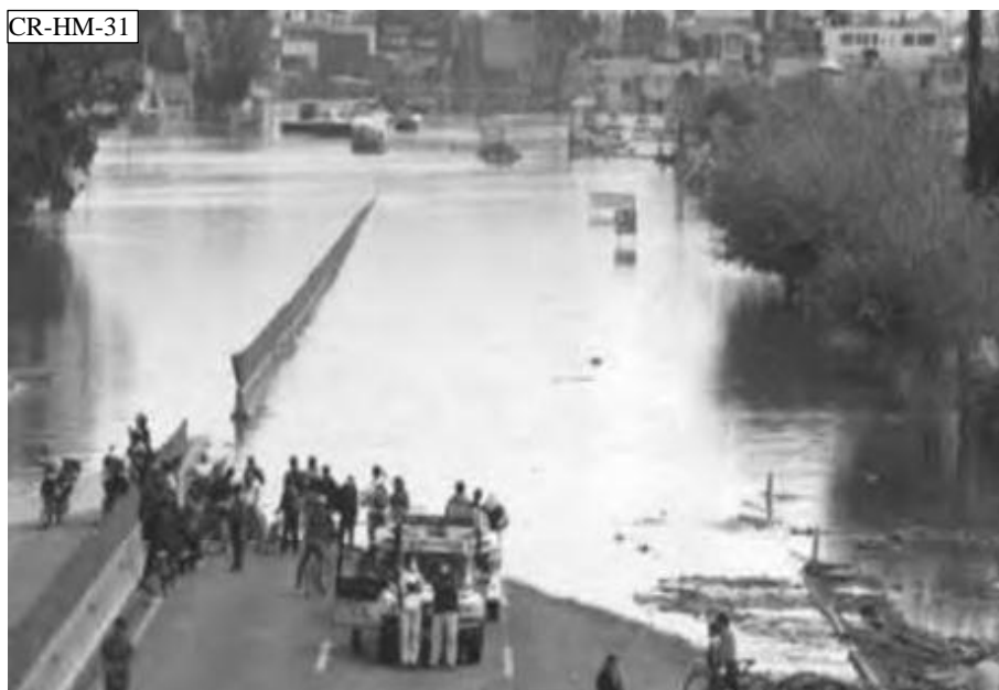
Fig. 4.28. Anegación de la superficie de rodamiento en la autopista México – Puebla km 28+500
