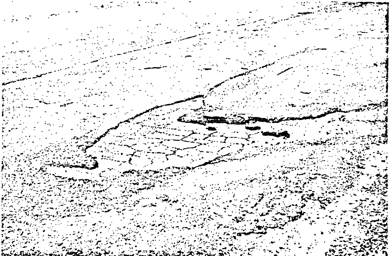
FIGURA 2-19 DESPLAZAMIENTO
