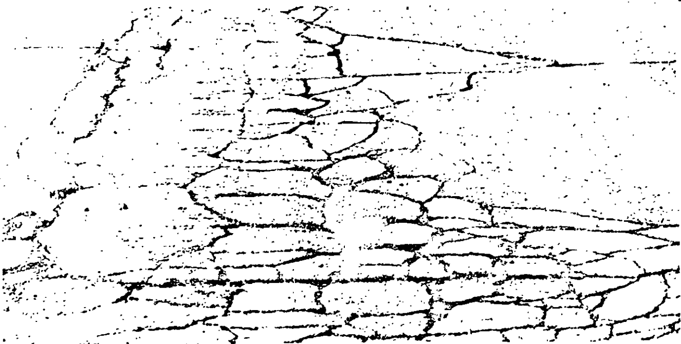
FIGURA 2-4 CUARTEO DE COCODRILO
