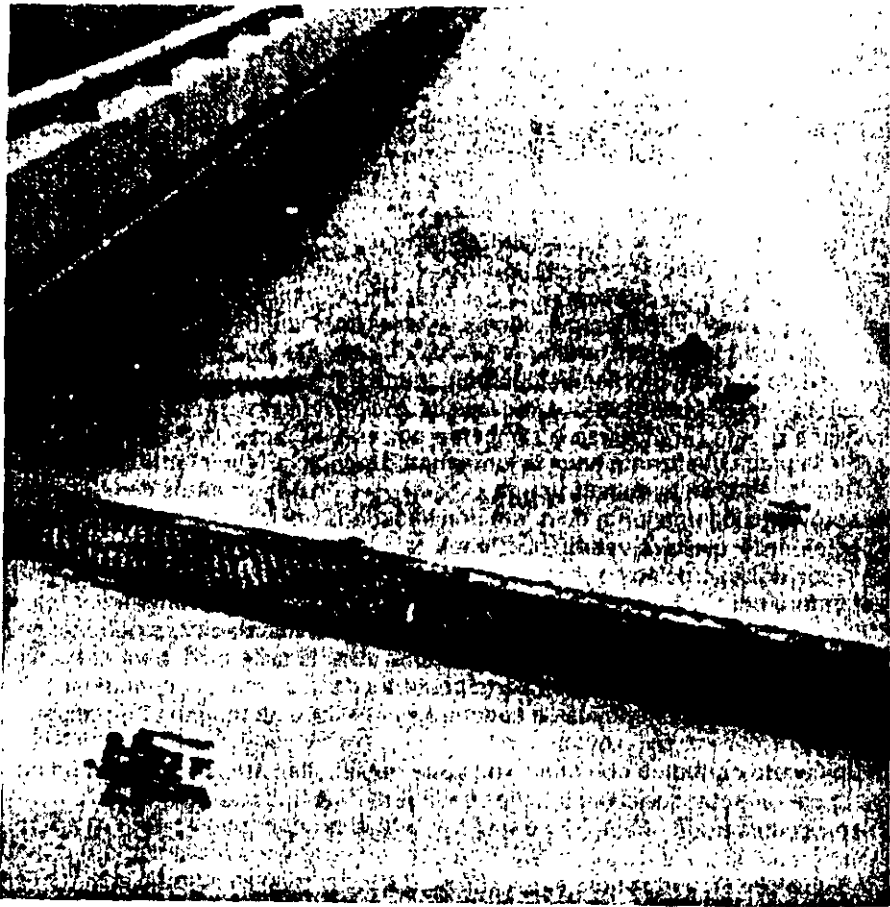
Figura 22. Dispositivo de dilatación elastomérico - uno de los primeros modelos.
