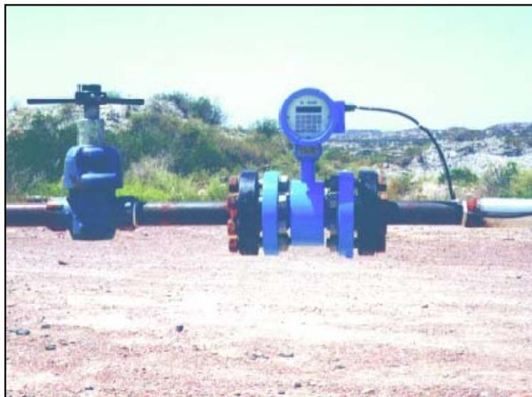
Fig. 3.74 Medidor instalado sobre una línea de hidrocarburos.
