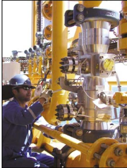
Fig. 2.7 Medidor Vx instalado en la plataforma Yombo.
