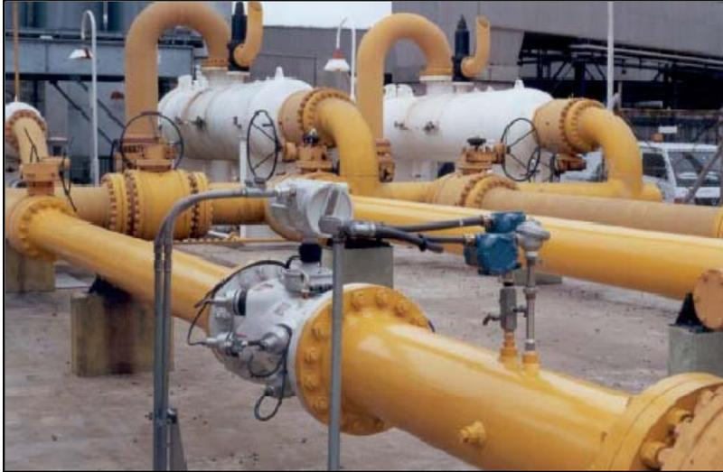
Fig. 3.67 Medidor instalado en planta de procesamiento.
