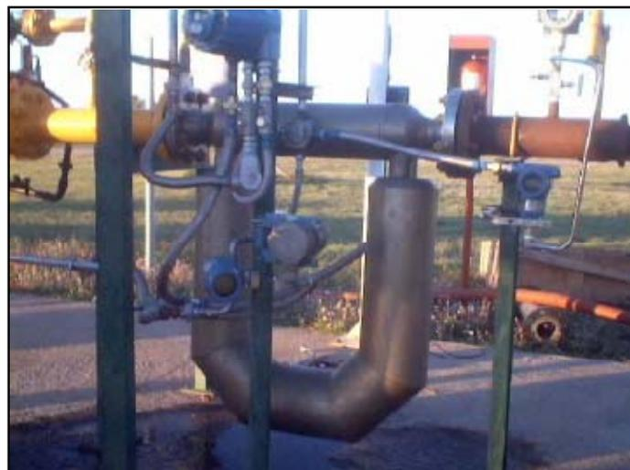
Fig. 5.4 Medidor Coriolis instalado en línea.
