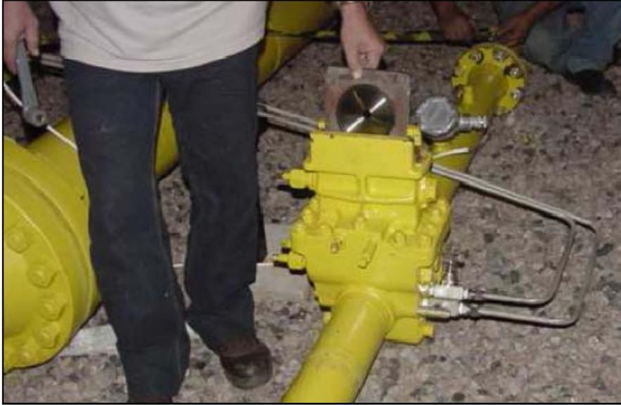
Fig. 3.27 Remoción de la placa de orificio en fitting.
