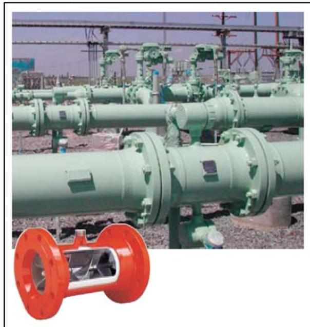
Fig. 3.55 Medidor de Turbina Smith Meter<sup>MT</sup> instalado en la terminal de un oleoducto.
