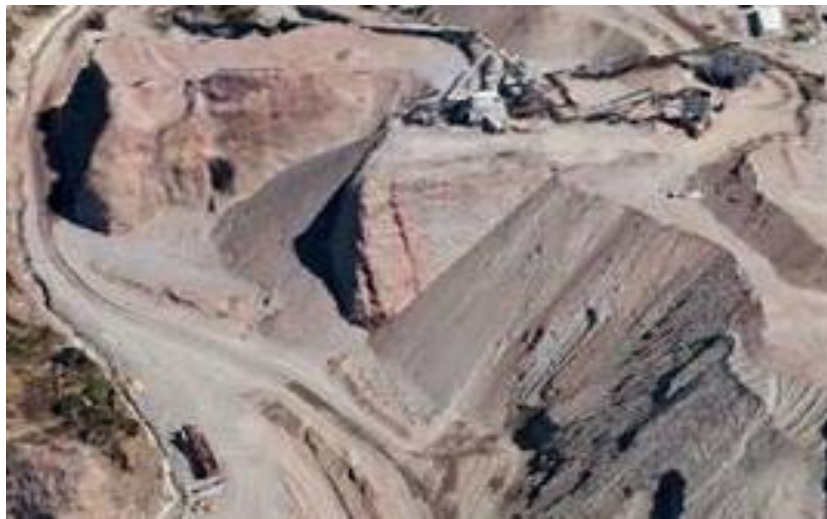
Figura 3.1: Vista lateral (de Sur a Norte) de “Molino 2”. Google Earth
