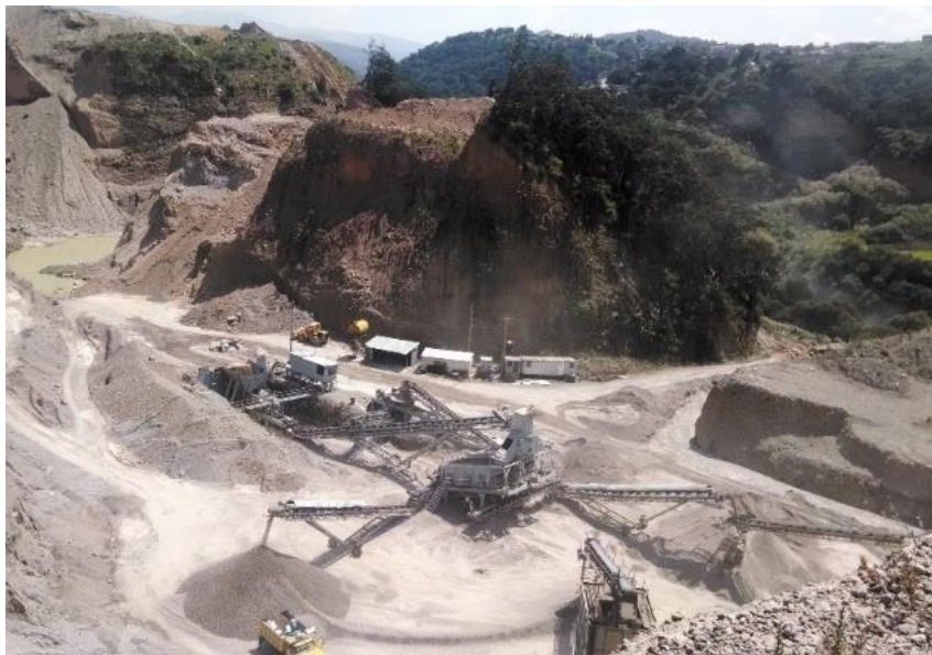
Figura 3.8: Vista lateral de cuerpo “Lote 4”, desde el cuerpo “Molino2”, Fotografía tomada en septiembre 2016
