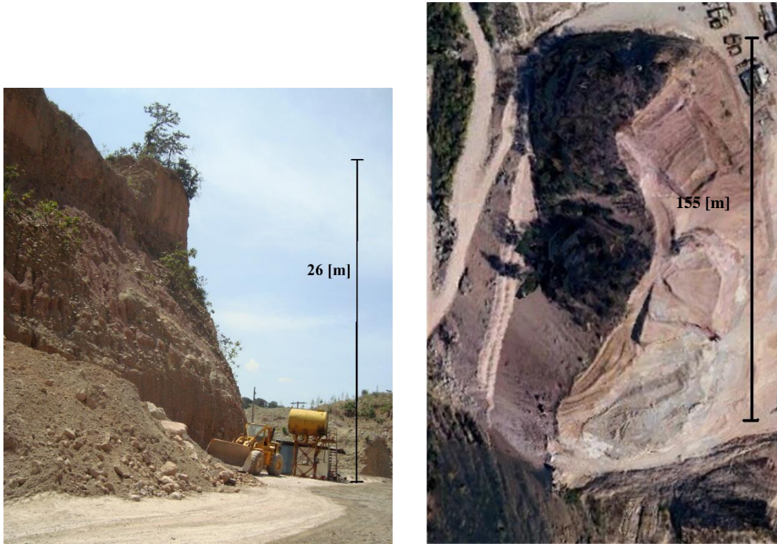
Figura 3.7: Vista lateral, fotografía tomada en septiembre 2016 y vista aérea del cuerpo “Lote 4”, Google Earth.
