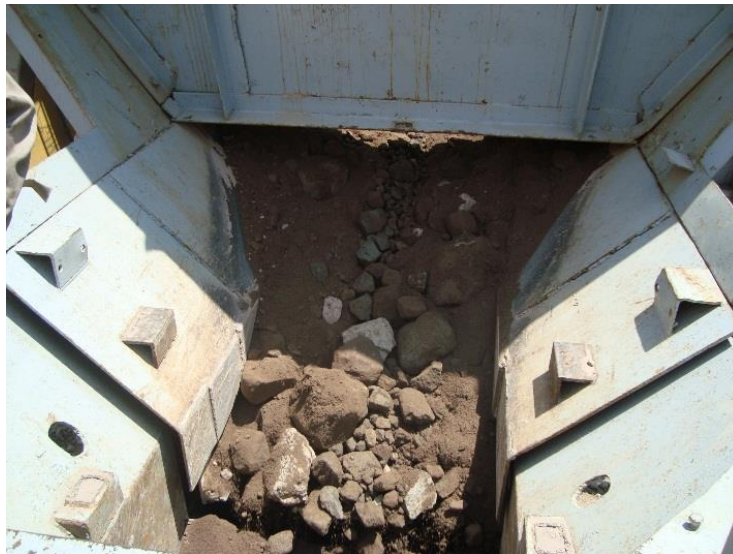
Figura 4.6 Trituradora de quijada. Fotografía tomada en septiembre 2016
