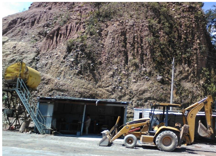
Figura 4.5: Fotografía que muestra la mala ubicación de los talleres. Septiembre 2016
