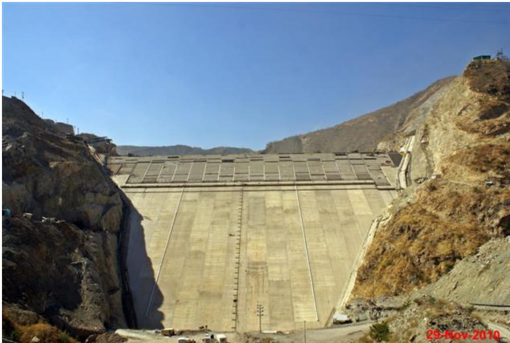
Fotografía 2. P.H. La Yesca. Presa de enrocamiento con cara de concreto. Foto bajada de la red de la página www.cfe.gob .
