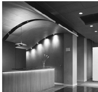
Figura 4.14 techo acústico curvo
