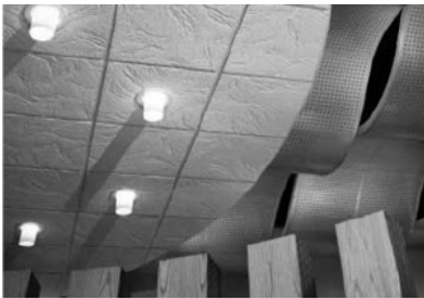
Figura 4.13 Techo acústico curvo
