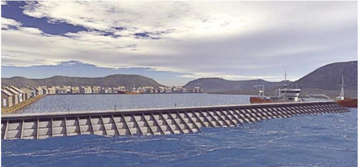
Figura 2.13 Representación artística de un dispositivo de rebase acoplado a un rompe olas
