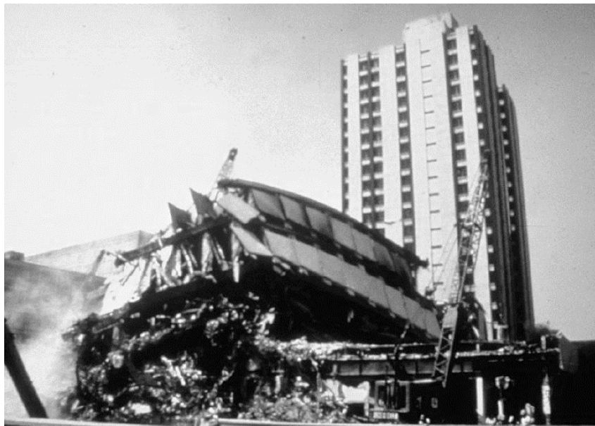
Figura 4.1. Colapso de edificio de complejo Pino Suárez.
