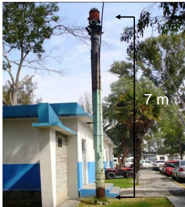
Fig. 27 Pozo que demuestra el hundimiento en San Juan de Aragón en el periodo 1936-2005.
