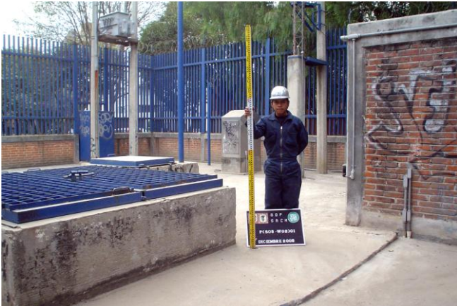
Fig. 14 Banco de nivel ubicado en instalaciones de sustracción de agua potable.
