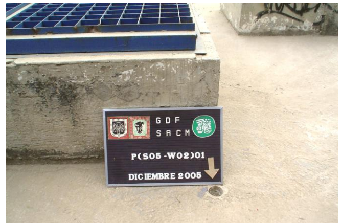
Fig. 15 Banco de Nivel en Pozo con placa circular de bronce.
