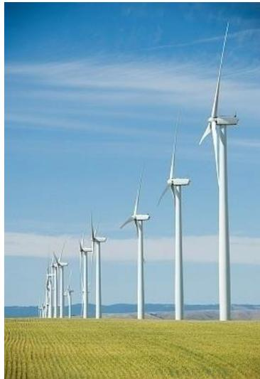
**Figura 1.2.** Turbinas de eje horizontal (HAWT).
