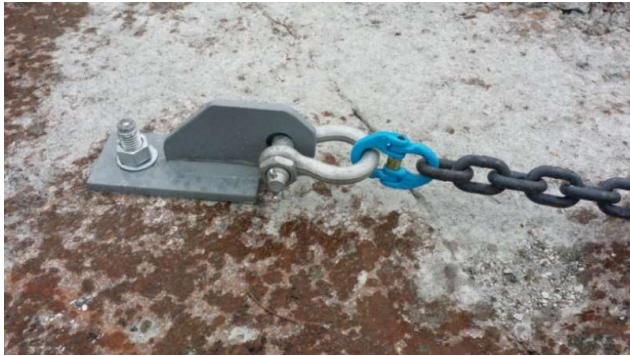
Figura 2.10 Ejemplo de anclaje de empotramiento
