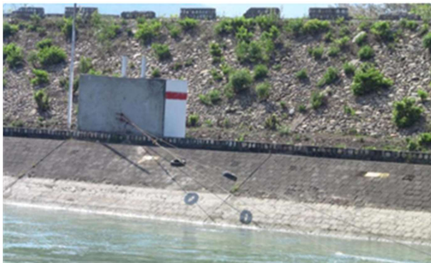
Figura 2.7 Ejemplo de anclaje de peso muerto
