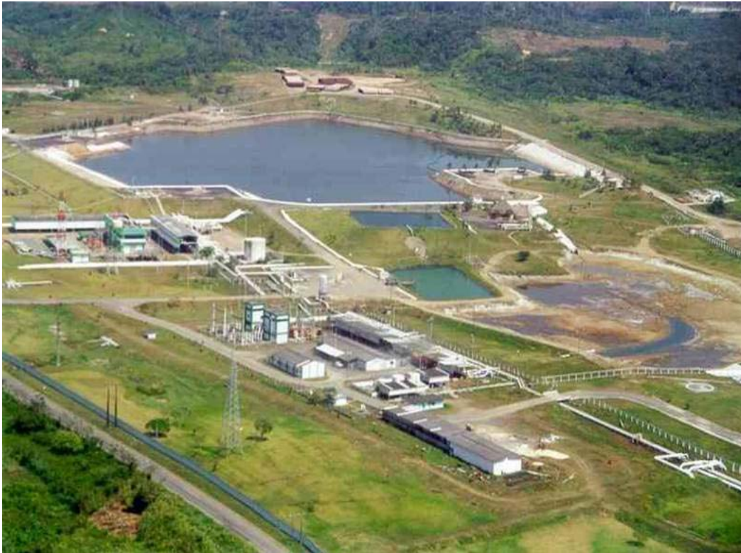
Figura 3.6 Vista panorámica del Centro de Almacenamiento Estratégico Tuzandépetl, Ver. Donde se pueden ver las presas de almacenamiento de salmuera (PEMEX 1999).
