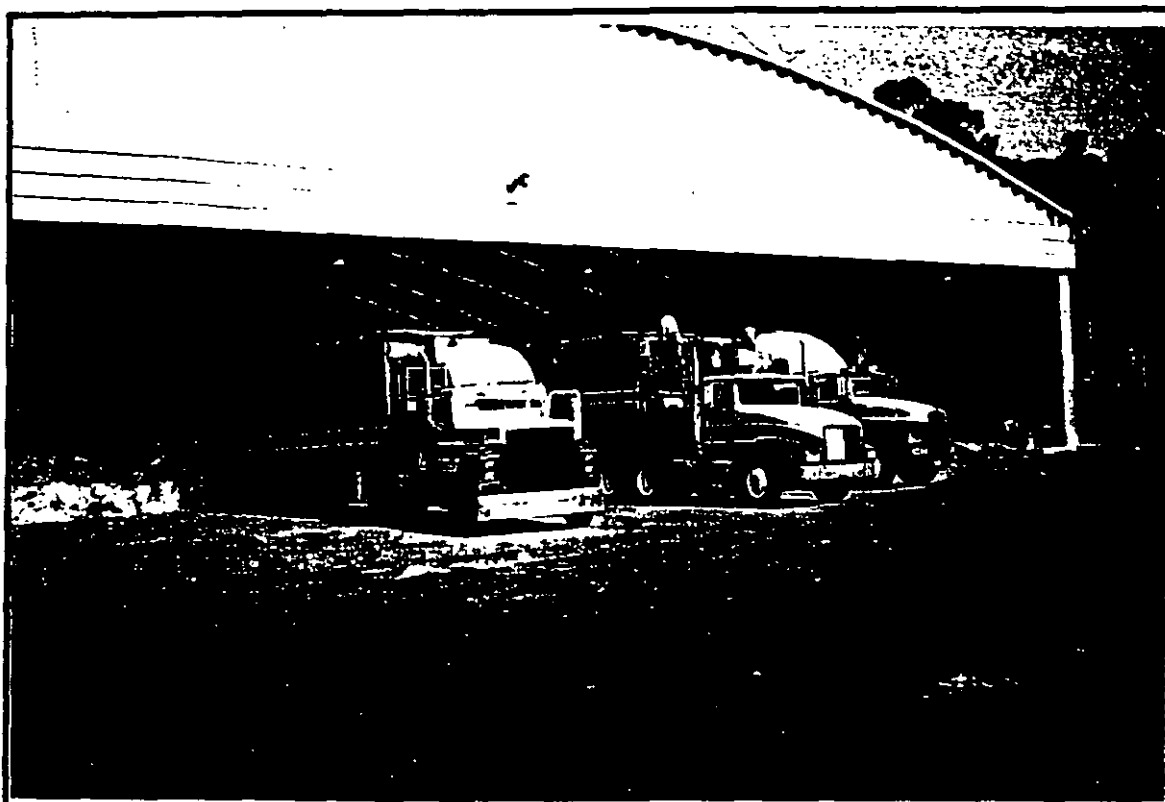
RECEPCION Y DESCARGA DE UNIDADES DE TRANSFERENCIAS EN PATIO DE RECEPCION DE MODULO II
