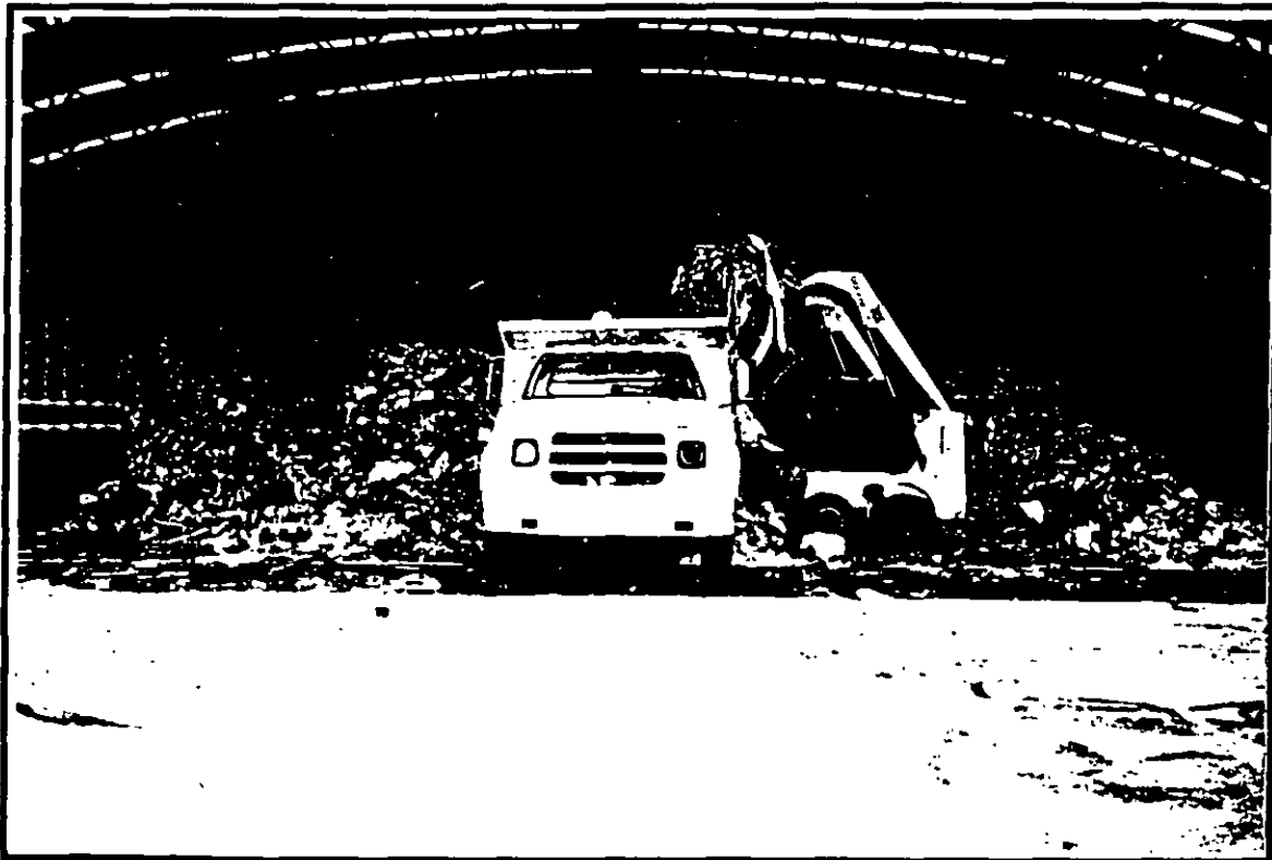
CARGA DE MATERIAL NO APROVECHABLE EN CAMION VOLTEO PARA DISPOSICION FINAL OPERACION
