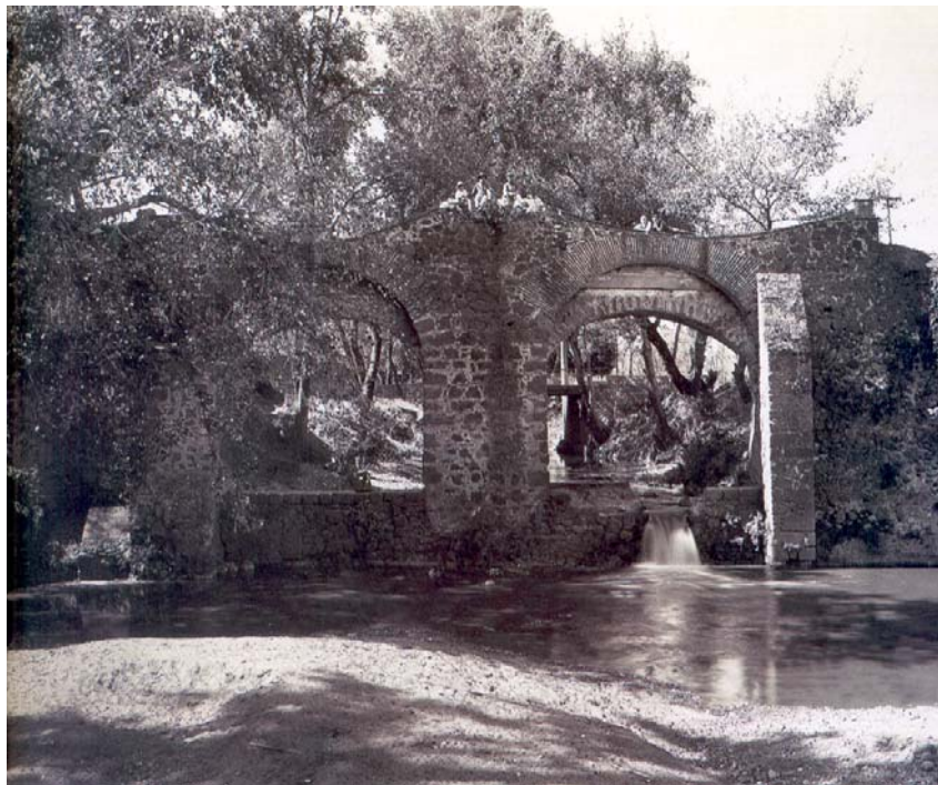
OBRAS HIDRÁULICAS FOTOGRAFÍA 1.11
