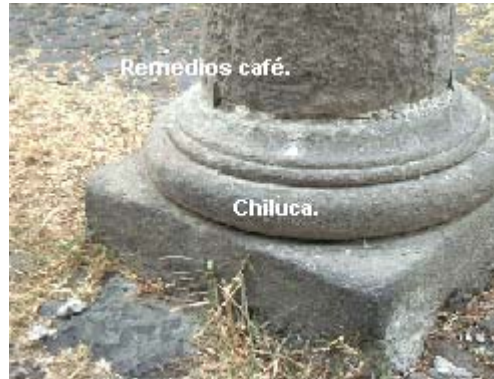
PEDESTAL DE LA COLUMNA CENTRAL FOTOGRAFÍA 2.4
