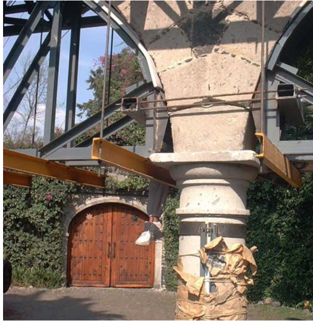
COLADO DE LA JUNTA CENTRAL FOTOGRAFÍA 4.17
