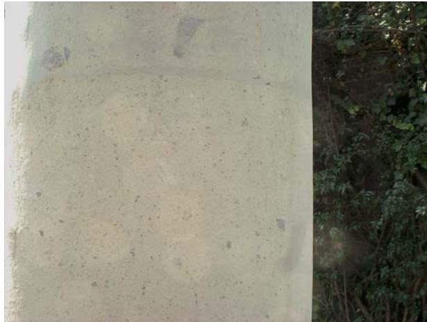
RESTAURACIÓN DE JUNTAS FOTOGRAFÍA 4.20
