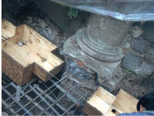
CIMBRA PARA APOYOS MÓVILES FOTOGRAFÍA 4.5
