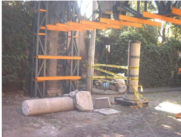
ARCOS SOPORTADOS SIN COLUMNA CENTRAL (TOMADA DESDE EL LADO ORIENTE) FOTOGRAFÍA 4.11
