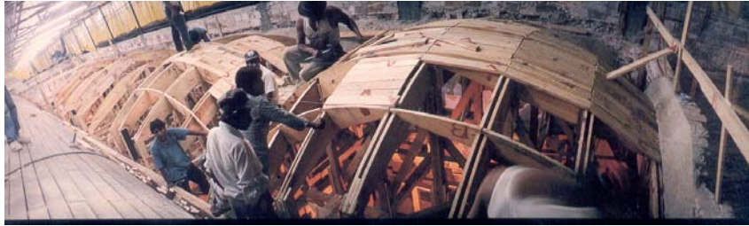
RESTITUCIÓN DE BÓVEDAS SEMIESFÉRICAS Ex-Convento de Santo Domingo, Ciudad de Oaxaca.
