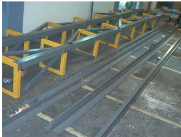
ARMADO DE COLUMNAS FOTOGRAFÍA 4.1
