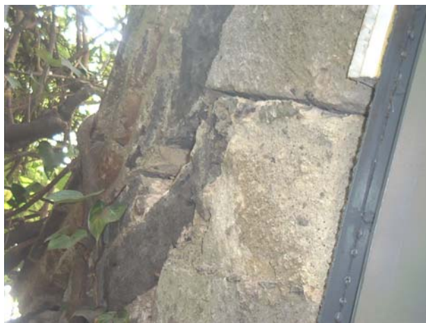
ARCOS ALINEADOS (APOYO SUR) FOTOGRAFÍA 4.14
