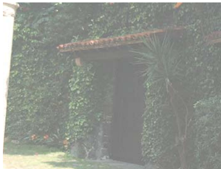
CORNISA CON VIGAS DE MADERA FOTOGRAFÍA 1.17
