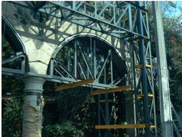
ESTRUCTURA METÁLICA LIBERADA FOTOGRAFÍA 4.18
