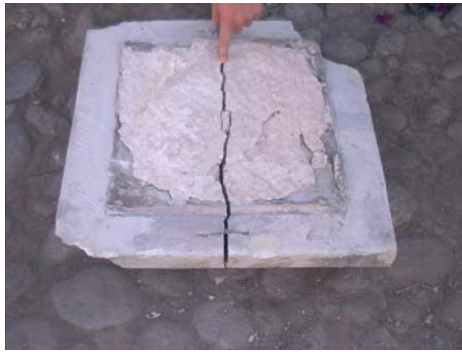
CAPITEL SECCIONADO FOTOGRAFÍA 2.5
