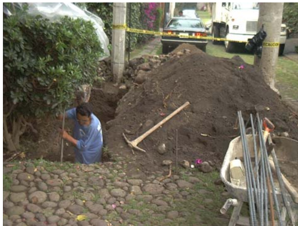
EXCAVACIÓN PARA CONSTRUIR LOS APOYOS FOTOGRAFÍA 4.4
