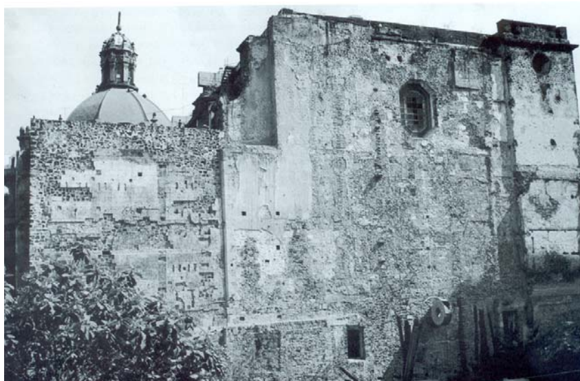
BÓVEDA REFORZADA CON CONCRETO Convento de San Francisco, Centro Histórico de la Ciudad de México FOTOGRAFÍA 1.1
