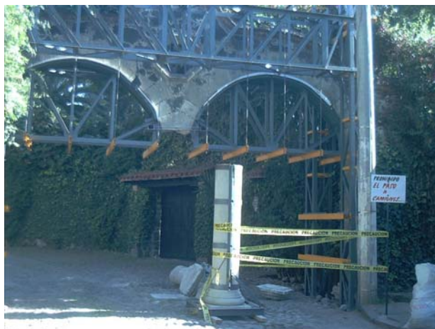
ARCOS SOPORTADOS SIN COLUMNA CENTRAL (TOMADA DESDE EL LADO PONIENTE) FOTOGRAFÍA 4.12
