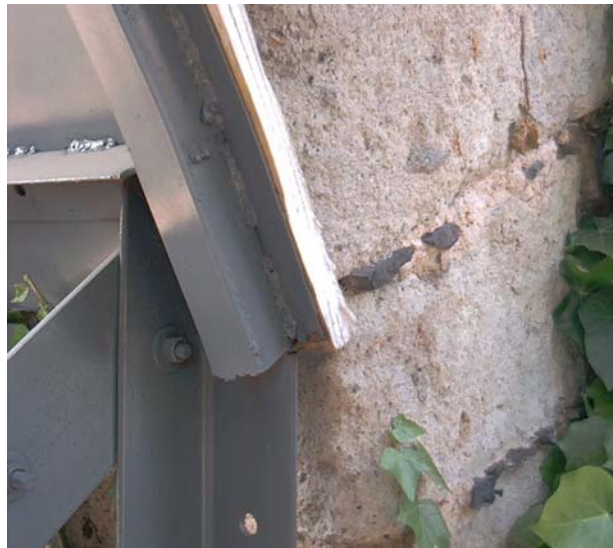
ARCOS SOBRE SUS APOYOS (APOYO NORTE) FOTOGRAFÍA 4.16
