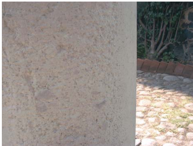
TEXTURIZACIÓN DE LA COLUMNA FOTOGRAFÍA 4.21
