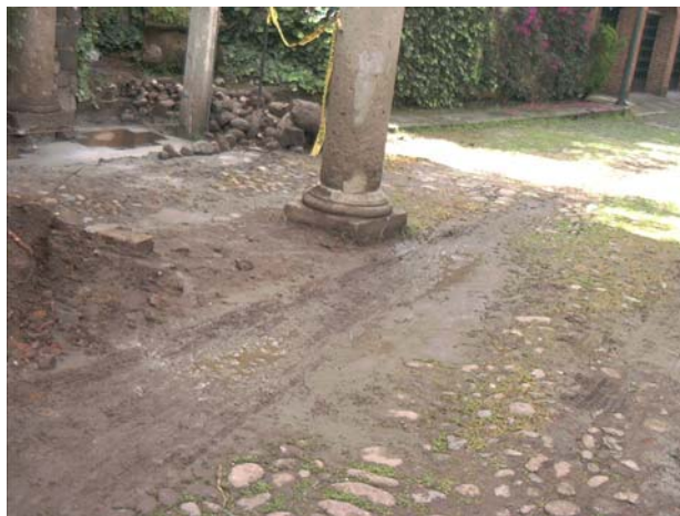
AVENIDA DESPUÉS DEL COLADO FOTOGRAFÍA 4.6
