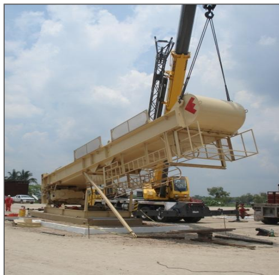
Figura 3.6. Instalación de la unidad
