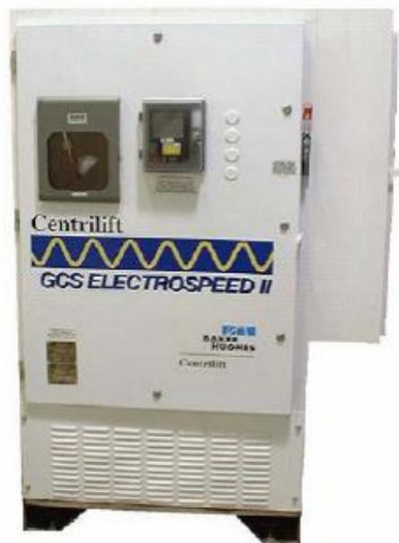
Figura 5.34. Variador de frecuencia<sup>11</sup>.
