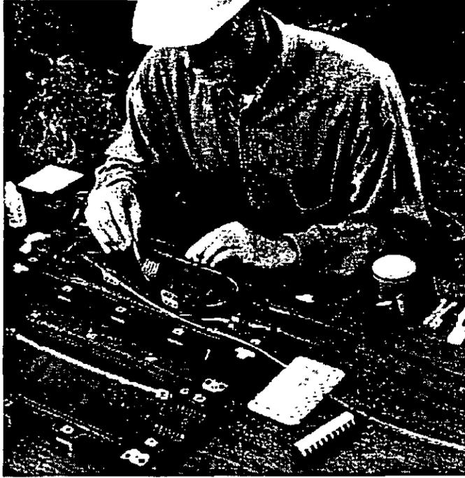
*Figura 16 Disposición de los empalmes realizados dentro del contenedor de empalmes.*
