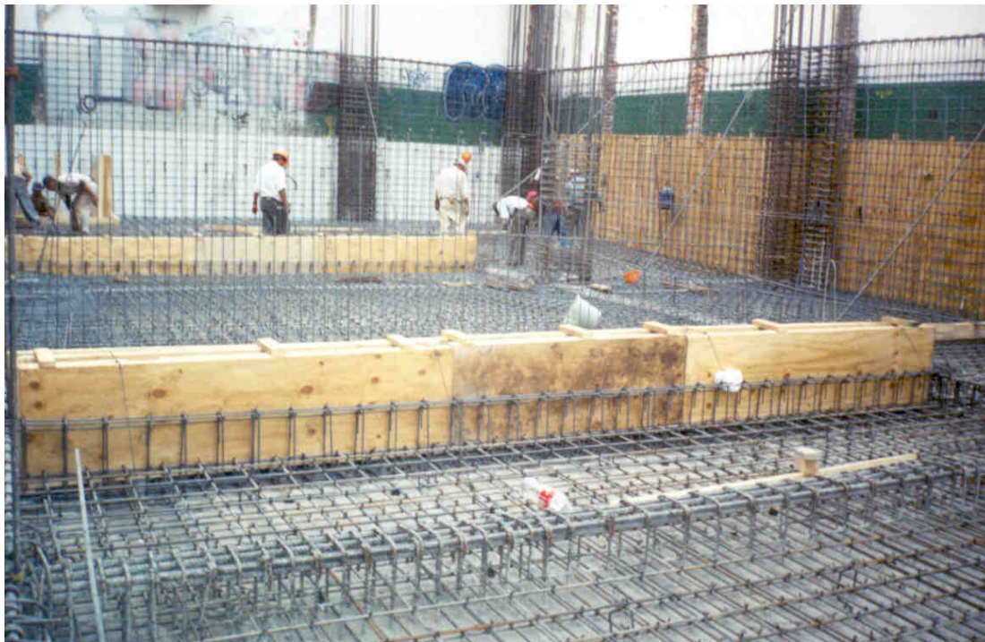
Foto 5.3 Armado general del cajón de cimentación.
