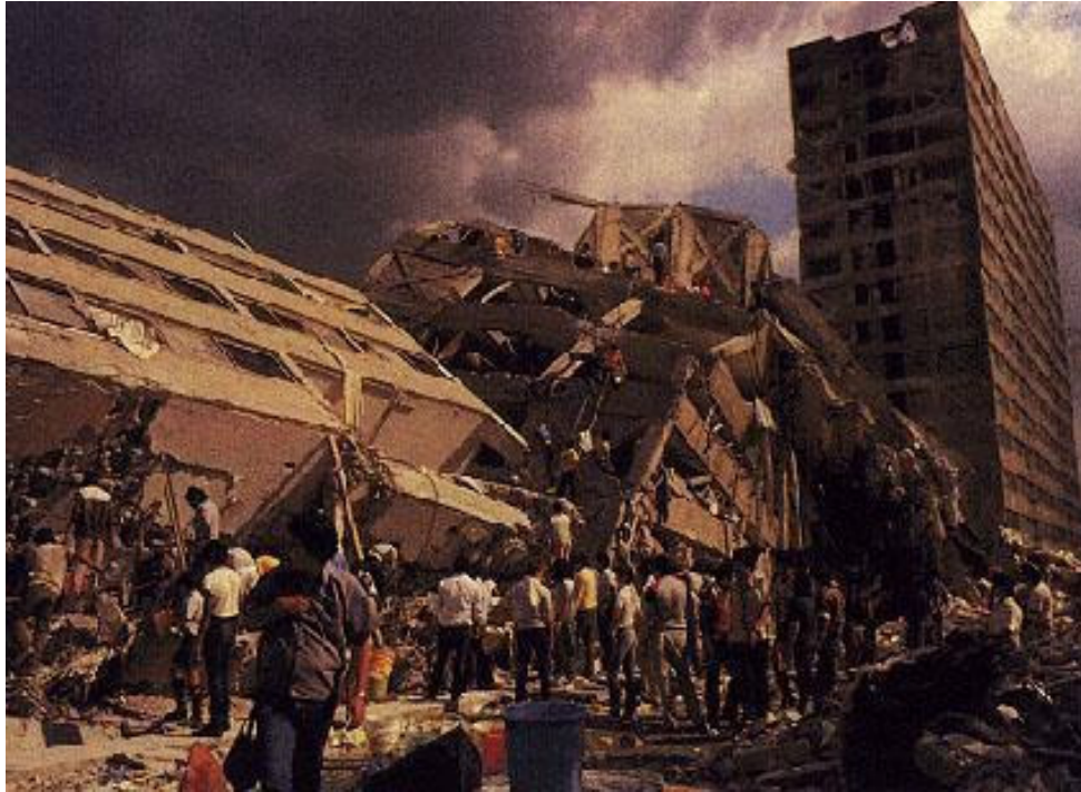
Foto 4.2 Falla general de la cimentación de un edificio en la Ciudad de México en el sismo del 19 de septiembre de 1985.
