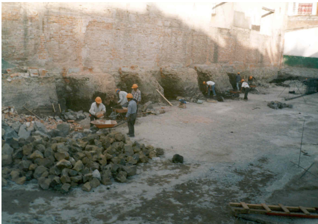
Foto 5.1 Vista de la estabilidad de colindancias.
