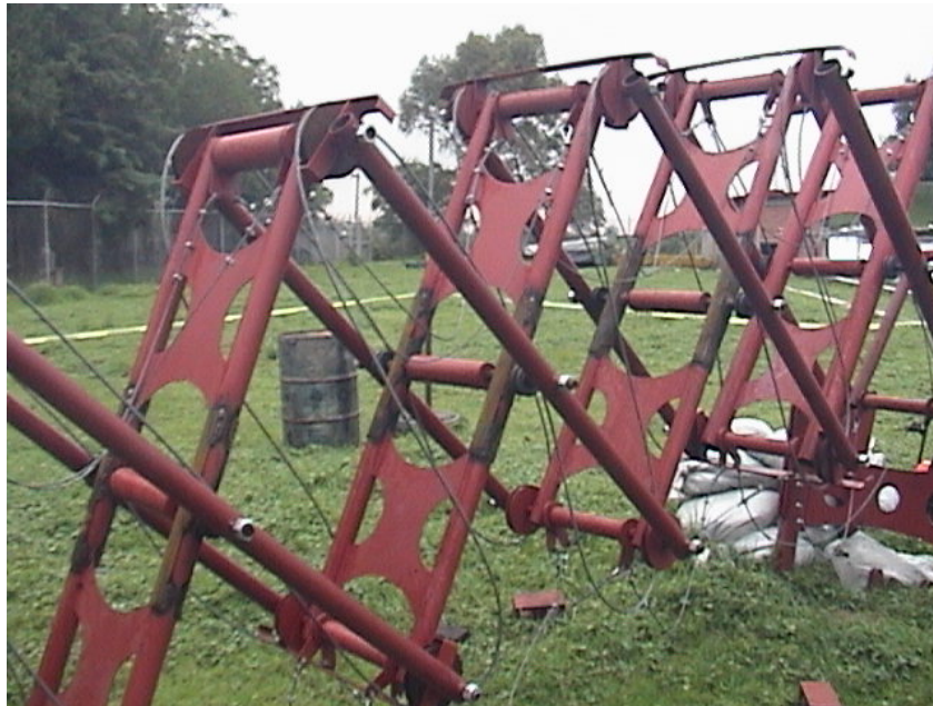
Fig. 6.28 Armado de los brazos y arreglo del cable
