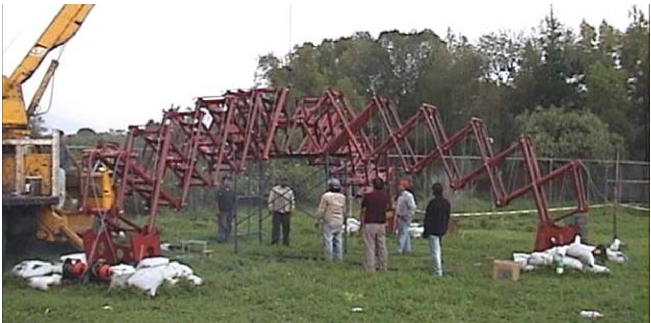
Fig. 6.32 Posición intermedia del izado
