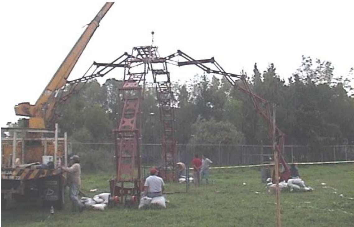
Fig. 6.33 Posición intermedia del izado
