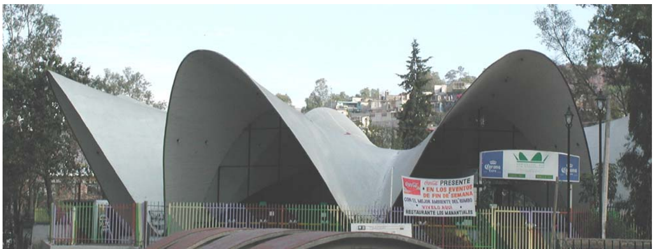
Fig. 1.3 Cascarón de doble curvatura inversa
