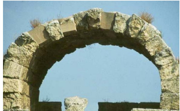
Fig. 1.17 Funicular inverso de la catenaria
