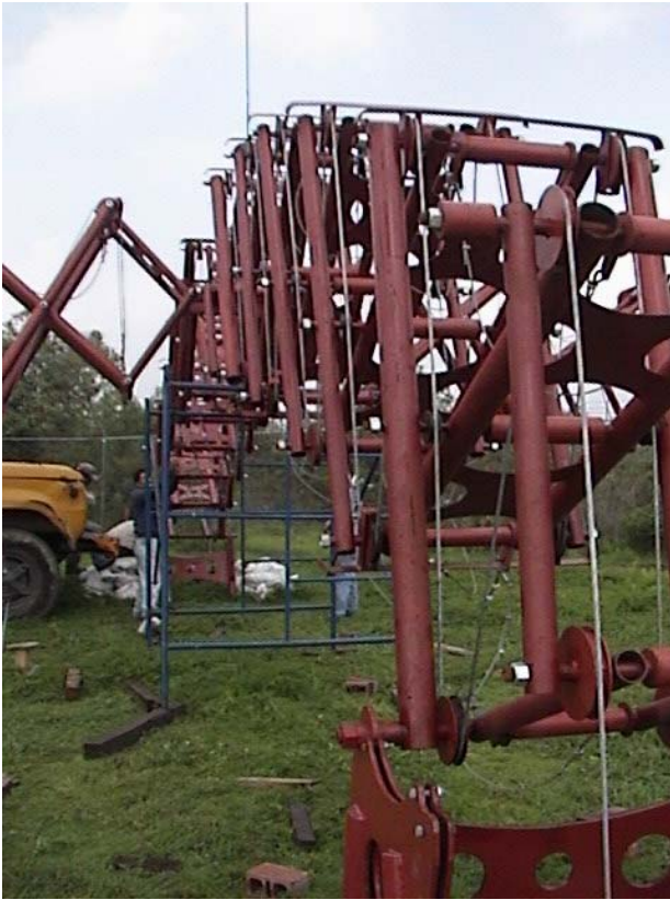
Fig. 6.30 Posición inicial elevado a 1.5 [m] y apoyado en un solo perno
