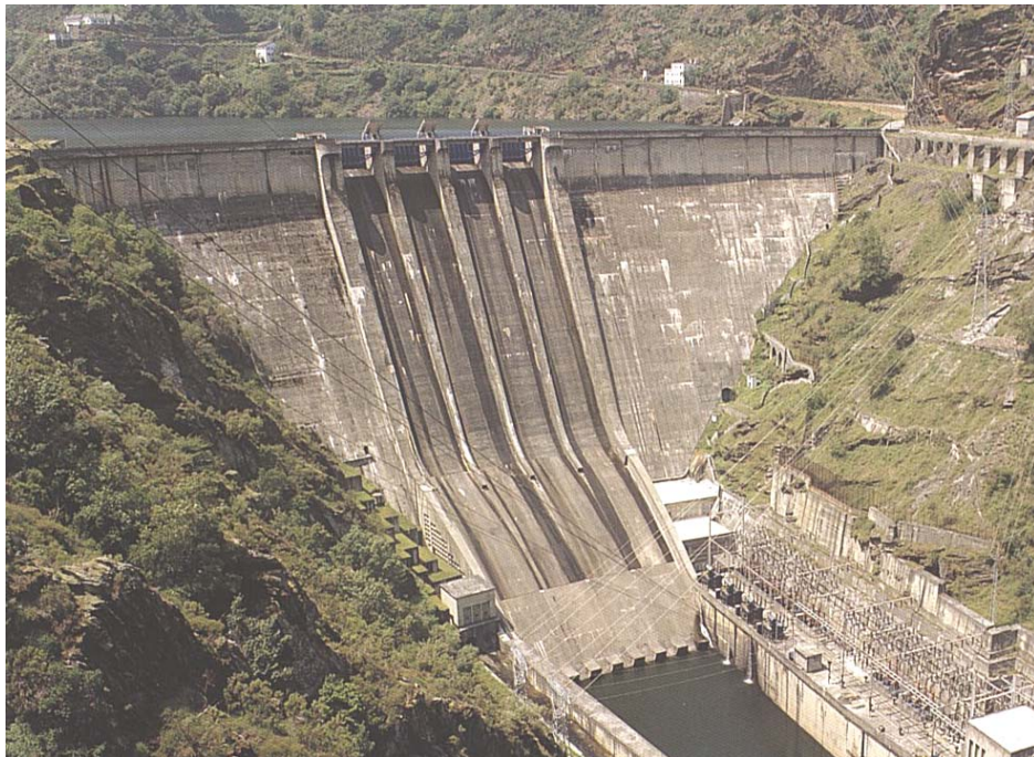
Fig. 1.1 Presa de gravedad
