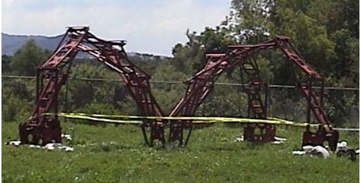
Fig. 6.37 Colapso de estructura
