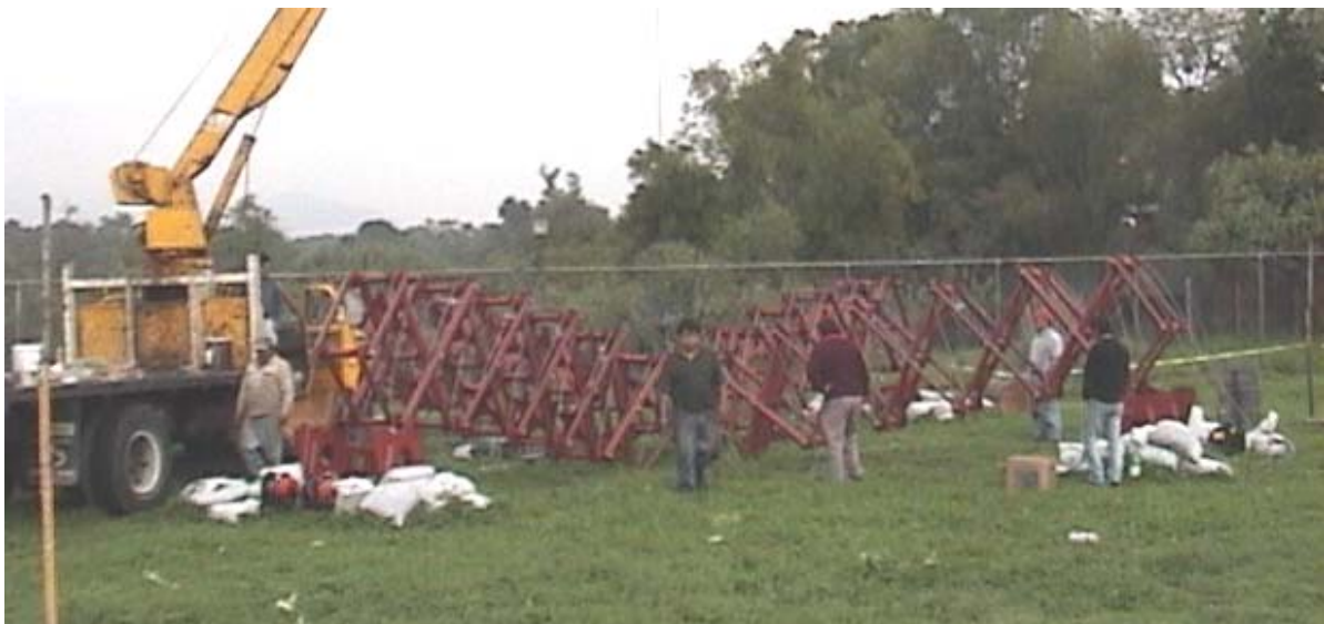
Fig. 6.29 Unión de los cuatro brazos con la linternilla al centro del claro
