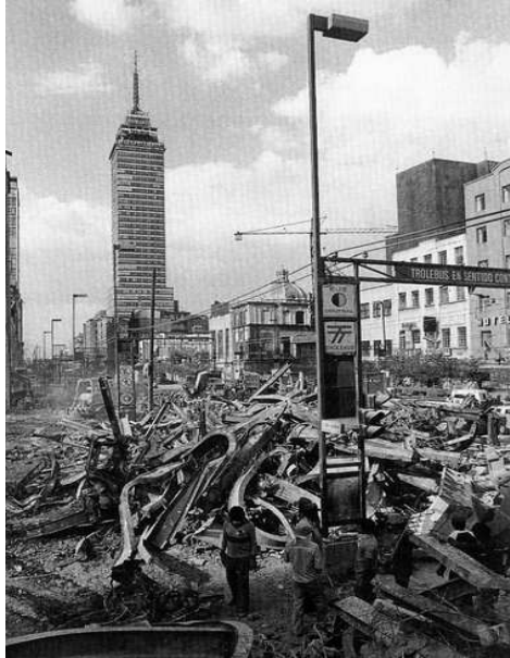
Fig III.5. Imagen de los daños causados por el sismo.(Fuente: http://entregeeks.files.wordpress.com/2009/09/terremoto_1985_torre_la.jpg )
