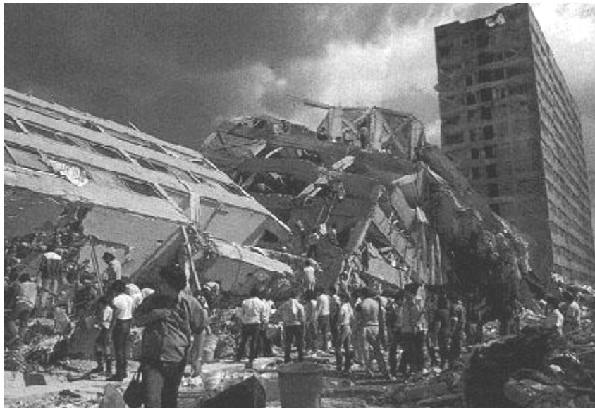
Fig. III.6. El edificio "Nuevo Leon" en Tlatelolco despues del temblor. (Fuente: http://3.bp.blogspot.com/_bcLwfYRrIU8/SNUcXsv6F5I/AAAAAAAAADU/yCJAxD6syCA/s400/terremoto-1985.jpg )
