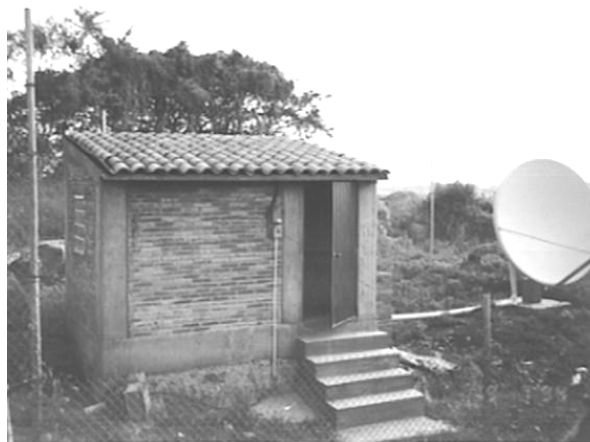
Figura II.7. Casetas que minimizan el ruido (Fuente: http://www.ssn.unam.mx/ ).
