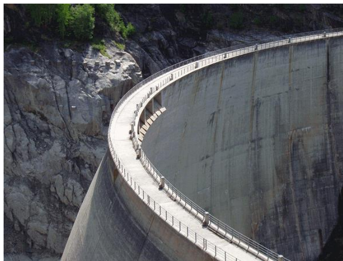
Figura 6. Imagen de la presa Gebidem, Suiza (www.structurae.net)
