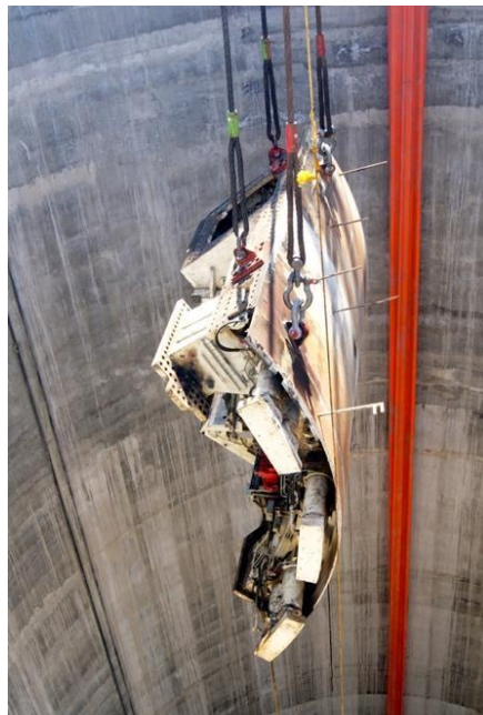
Fig. 2.7. Introducción de las partes de una TBM a una galería de montaje. 63
