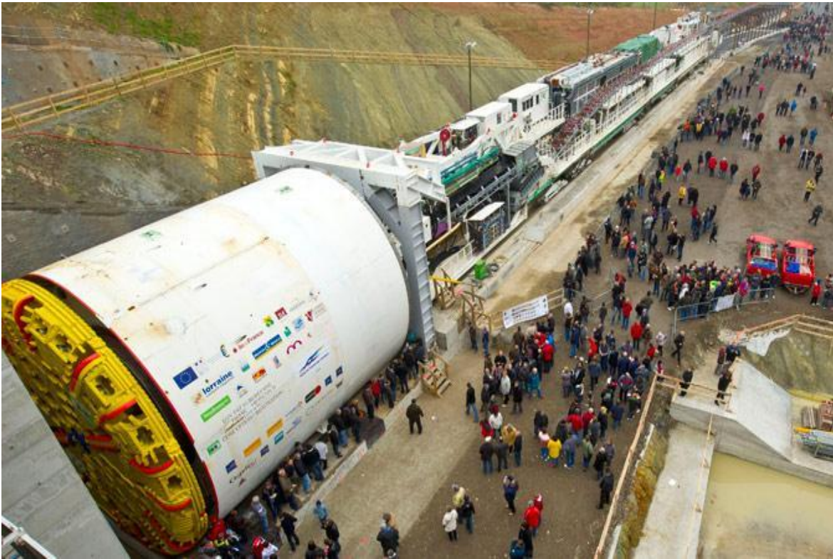
Fig. 2.3. TBM del tipo EPB en portal de entrada. 58
