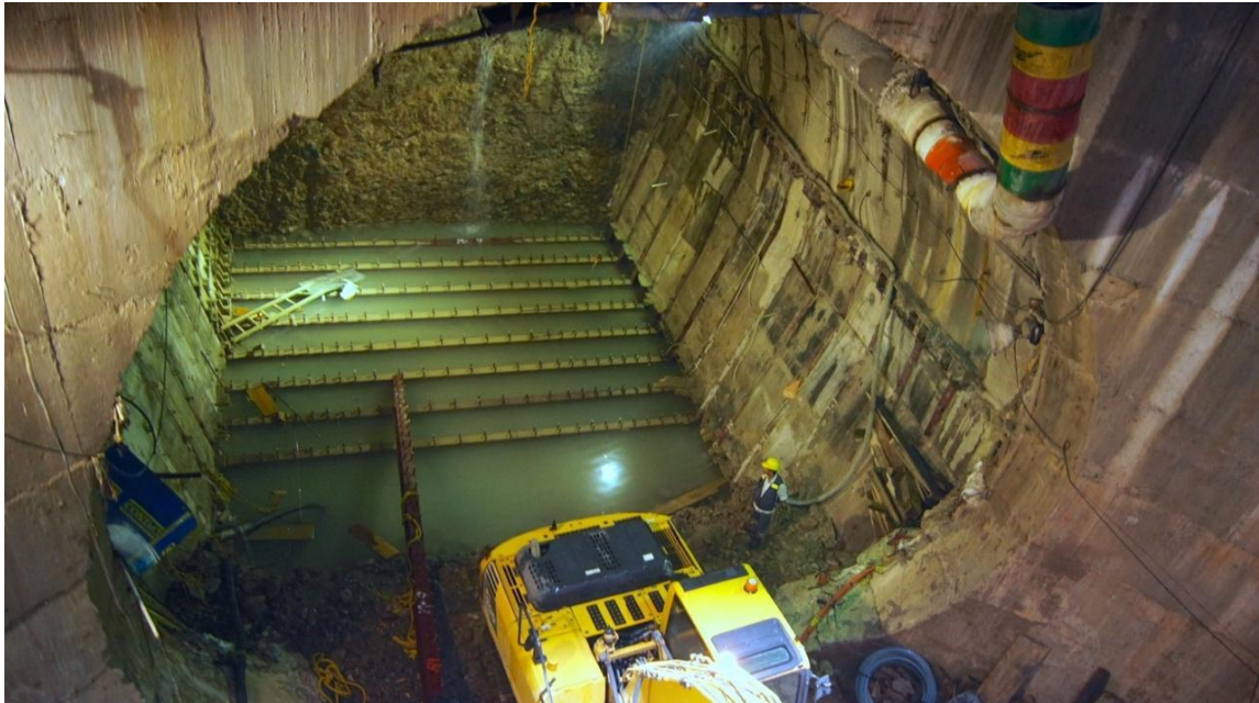
Fig. 2.5. Construcción de una galería de montaje. 60
