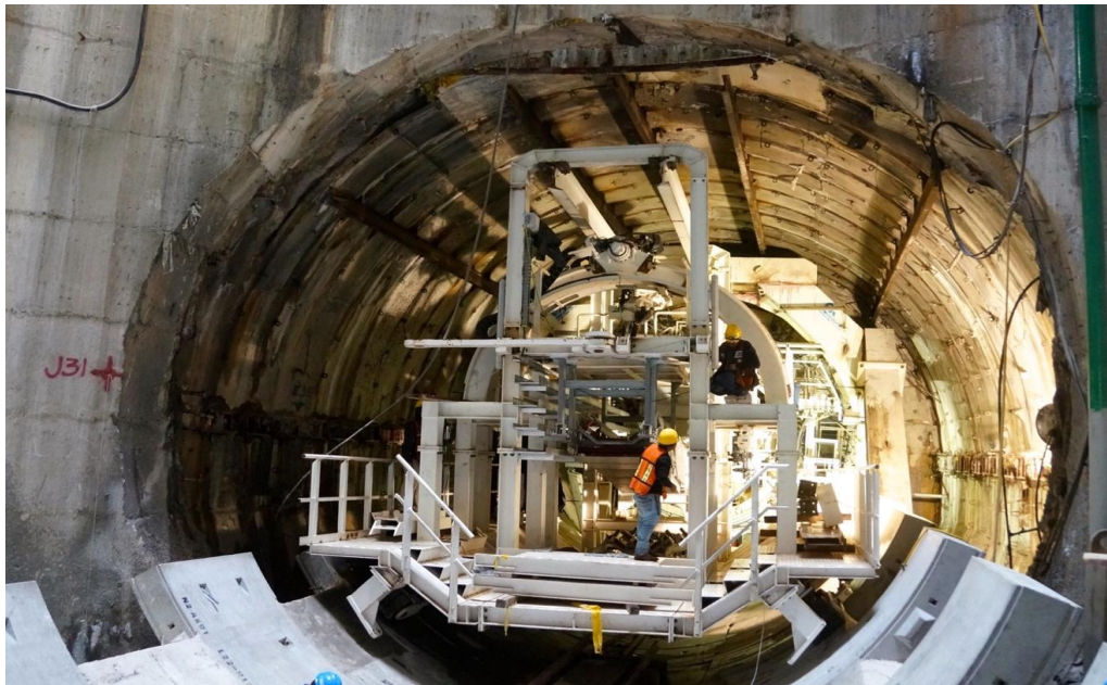
Fig. 2.2. Instalación de los primeros carros de la TBM. 56
