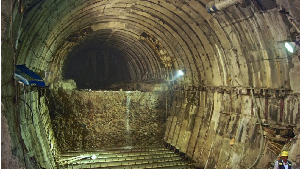
Fig. 2.6. Construcción de una galería de montaje. 62
