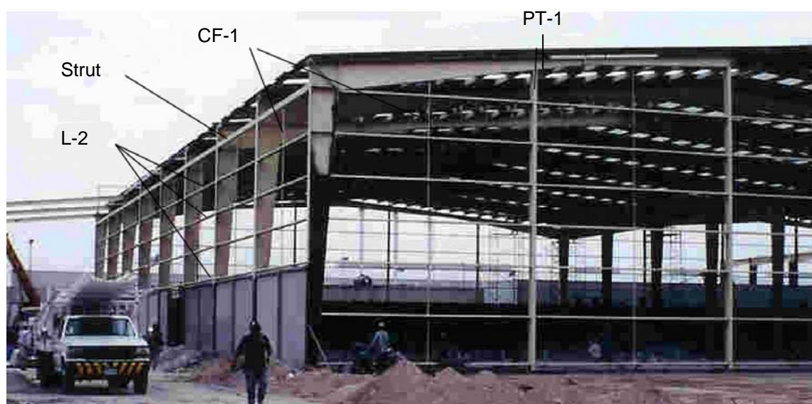
Foto 3.10 Vista de eje “1” y eje “E” largueros, contraflambeos y postes PT-1 para fachada
