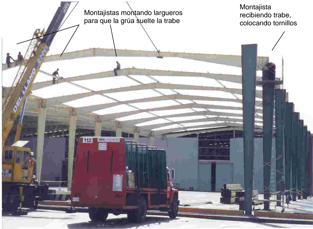
Foto 3.3 Montaje de largueros para dar rigidez a la trabe recién montada
