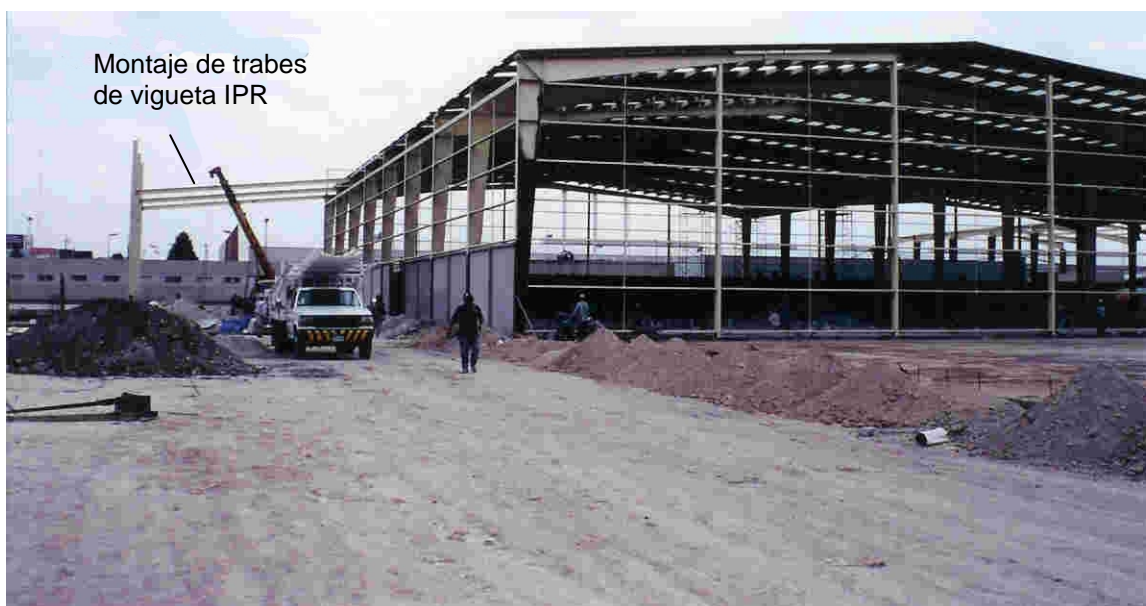
Foto 3.8 Montaje de traves de IPR para cuarto de máquinas
