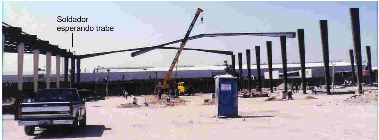
Foto 3.2 Maniobra de montaje y armador esperando trabe
