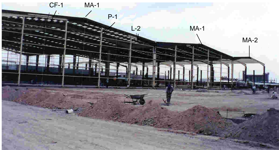
Foto 3.9 Estructura de fachada en eje 1
