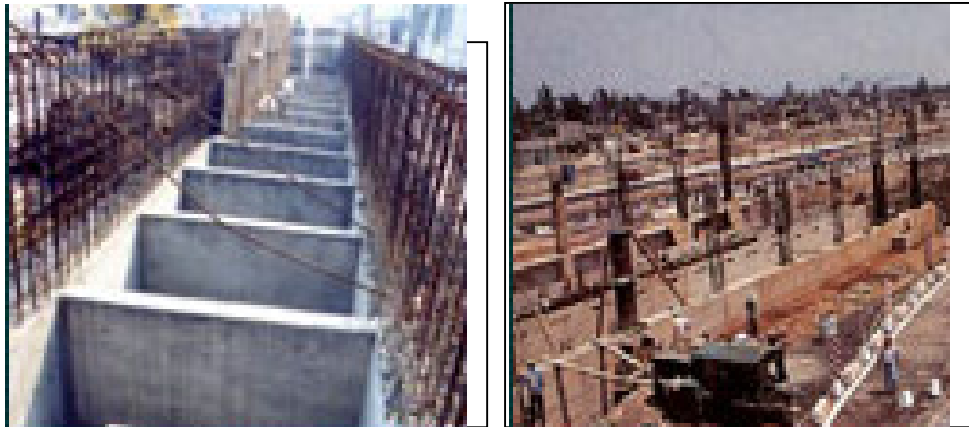
FIGURA 1.10 A y B CONSTRUCCION DE LA LÍNEA B EN SU TRAMO SUPERFICIAL EN EL ESTADO MÉXICO EN LA ESTACIÓN NEZAHUALCOYOTL(ANTES CONTINENTES).
