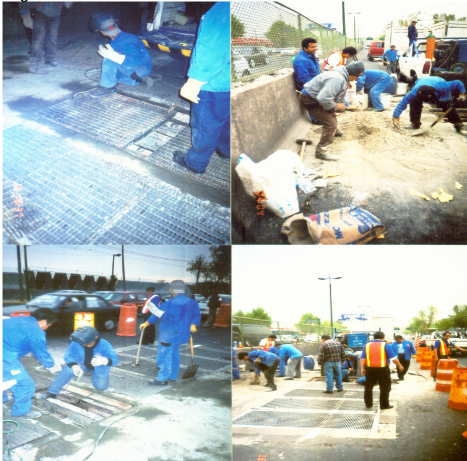
FIGURA 4.8 A,B,C,D SE APRECIA LA REPARACIÓN URGENTE DE UNA REJILLA VEHICULAR UBICADA A UN COSTADO DEL AICM POR PERSONAL DEL MISMO SISTEMA Y CON RECURSOS PROPIOS, LO QUE TARDO MAS DE 24 HRS PARA SU REPARACIÓN.
