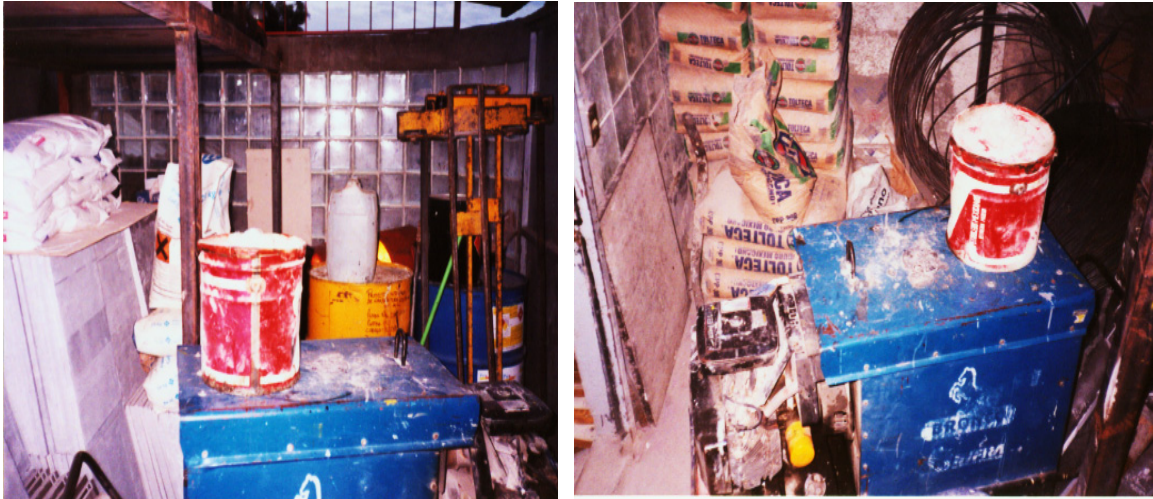
EN LA FIGURA 5.10 SE MUESTRAN DOS ANGULOS DE LA BODEGA DE MATERIALES DE ALBAÑILERÍA, DONDE SE OBSERVAN LAS MALAS CONDICIONES DE ALMACENAJE.
