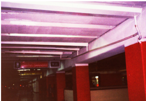
FIGURAS 4.10 A, B MUESTRAN CHAROLAS PARA CAPTACIÓN DE AGUAS PROVENIENTES DE FILTRACIONES DEBIDAS A LOS MANTOS FREÁTICOS EN LAS ESTACIONES DE LÍNEA 6
