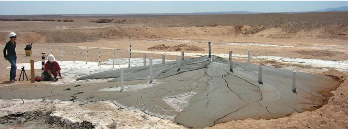
Figura 8. Jales espesados, proyecto Esperanza, Chile (SRK Consulting, 2010).
