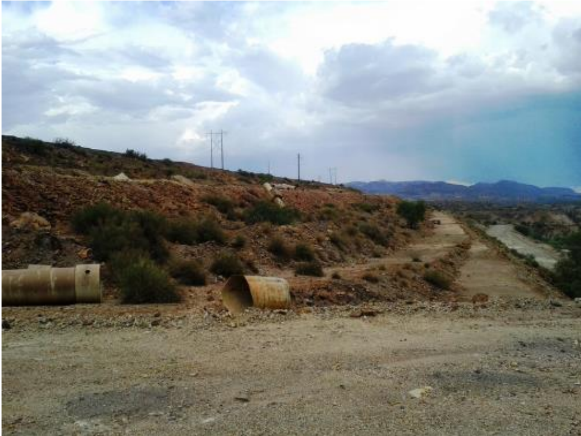
Figura 27. Bermas actuales en la cortina contenedora.
