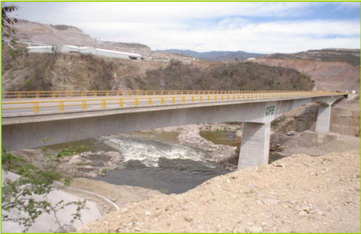
Fotografía I.1. PUENTE SANTIAGO 3 MARZO 2005
