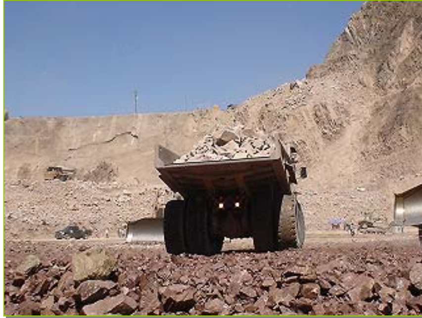
Fotografía III.5. Llegada del camión fuera de carretera desde el banco "El Vertedor" con material tipo 3B.
