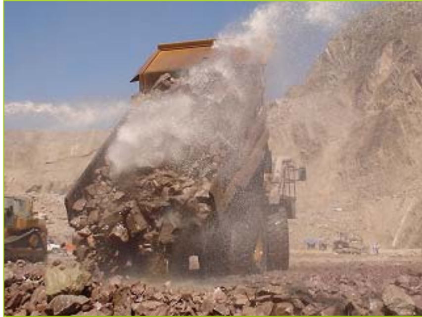
Fotografía III.7 Descarga del material mientras sigue siendo humectado.
