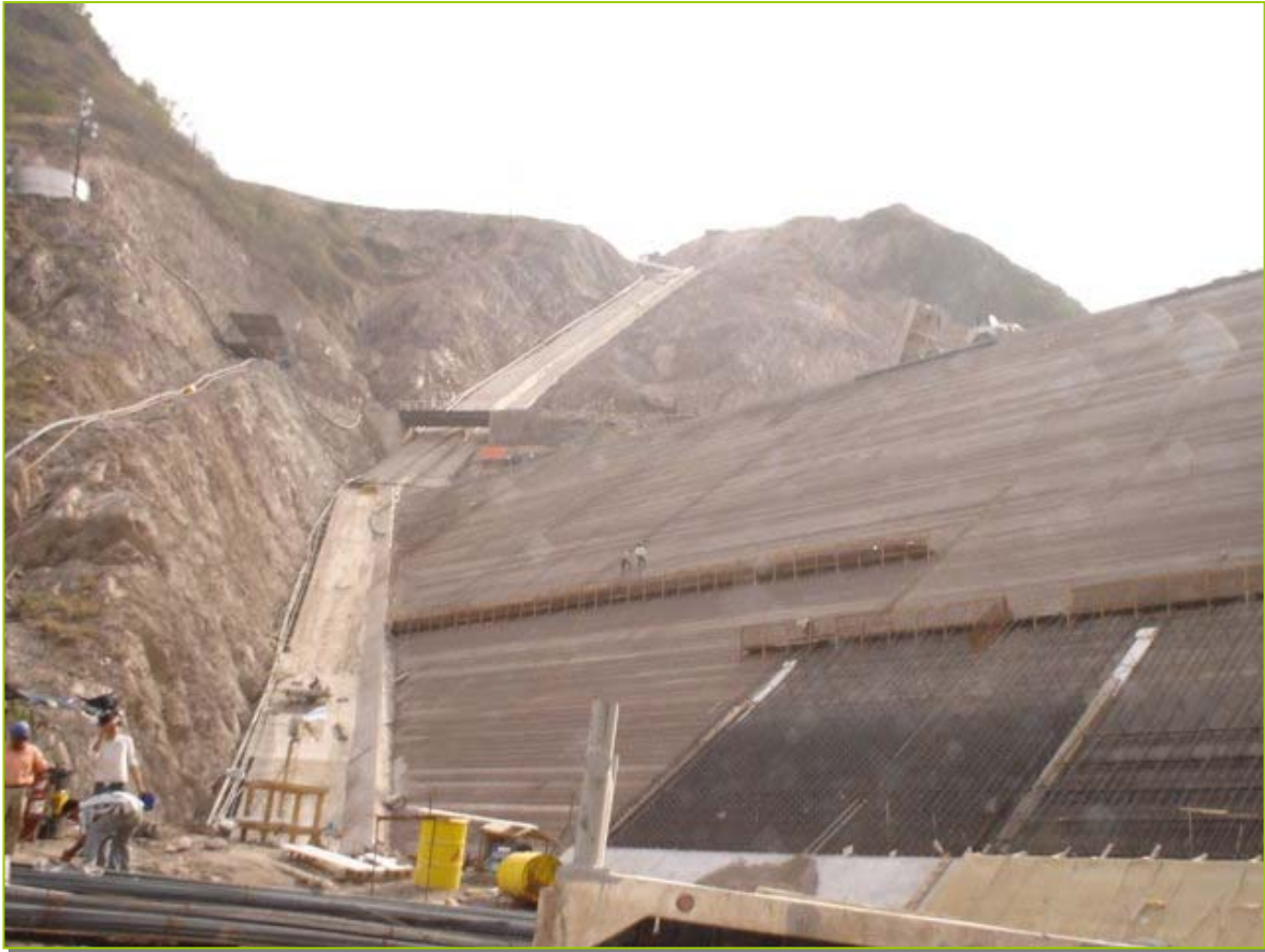
Fotografía II.1. PLINTO MARGEN IZQUIERDA.
