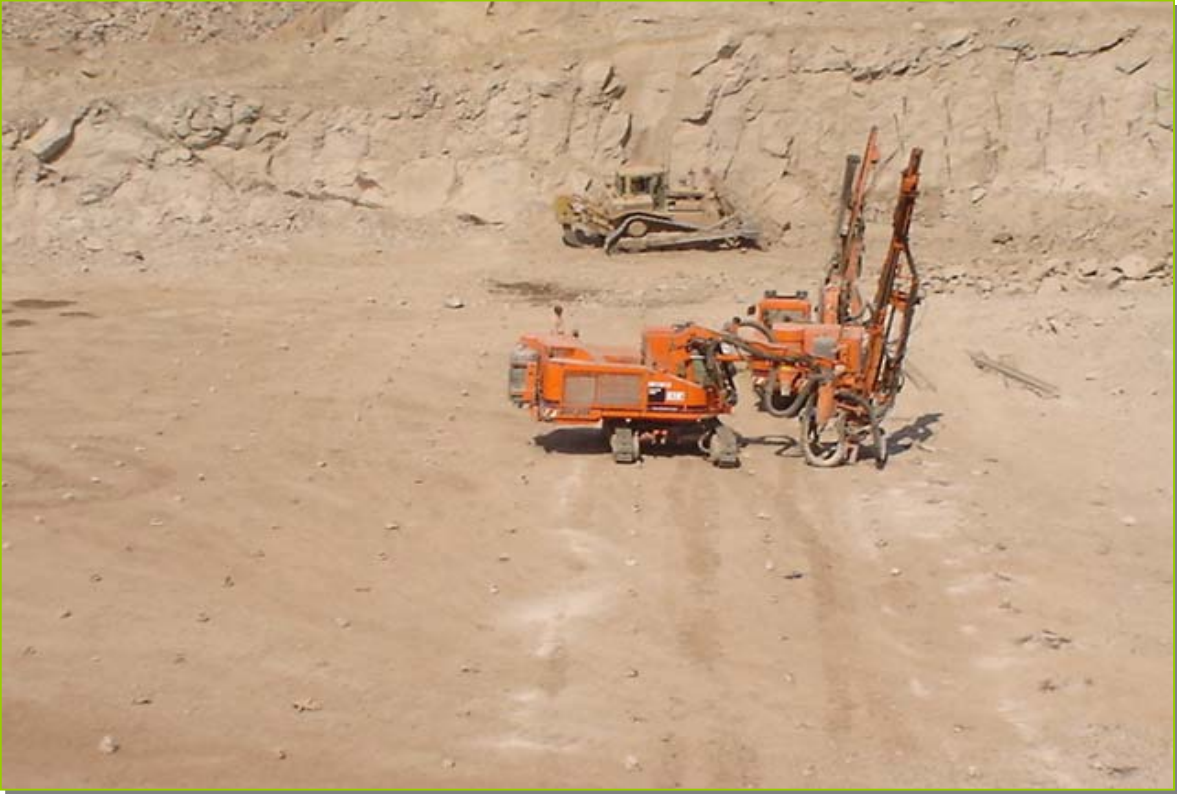
Fotografía III.1 PERFORADORA RANGER 500, TERMINANDO DE HACER LOS BARRENOS DE LA PLANTILLA PARA LA VOLADURA. BANCO EL VERTEDOR.
