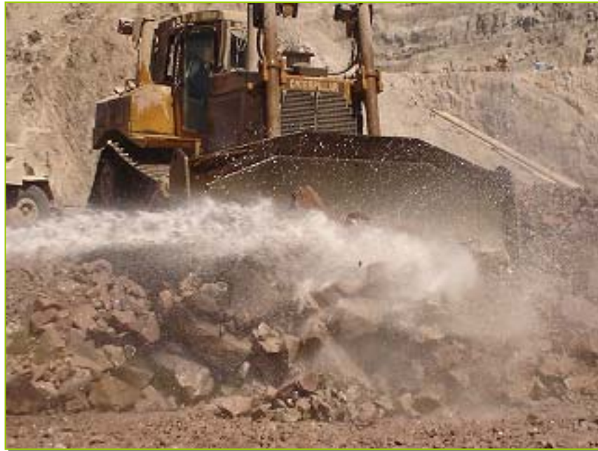
Fotografía III.11. Finalmente se alcanza el espesor solicitado, que para el caso Particular del material 3B es de 80 cm.
