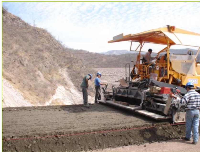
Fotografía III.3 EL ESPARCIDOR DEMAC, COLOCA EL MATERIAL CON EL ESPESOR REQUERIDO
