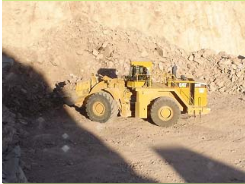
Fotografía III.3. Extracción de material con cargador frontal
