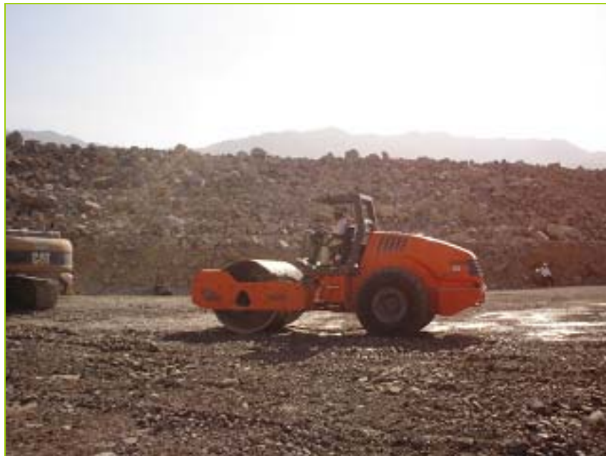
Fotografía III.12. Posterior a la colocación, se compacta usando compactador de rodillo liso vibratorio de 10 o 12 ton, dando de 6 a 8 pasadas.
