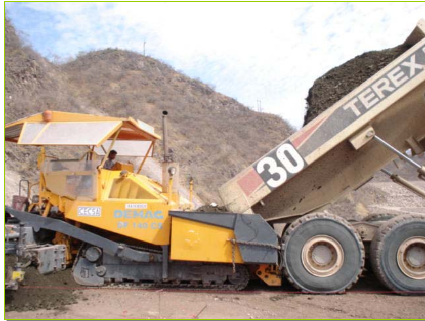
Fotografía III.2 VOLTEO DEL MATERIAL 2, AL ESPARCIDOR DEMAC, PREVIAMENTE NIVELADO.
