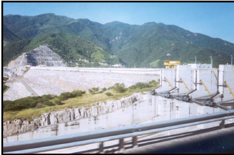
Fig.I.14.- Central Hidroeléctrica Aguamilpa, Nayarit
