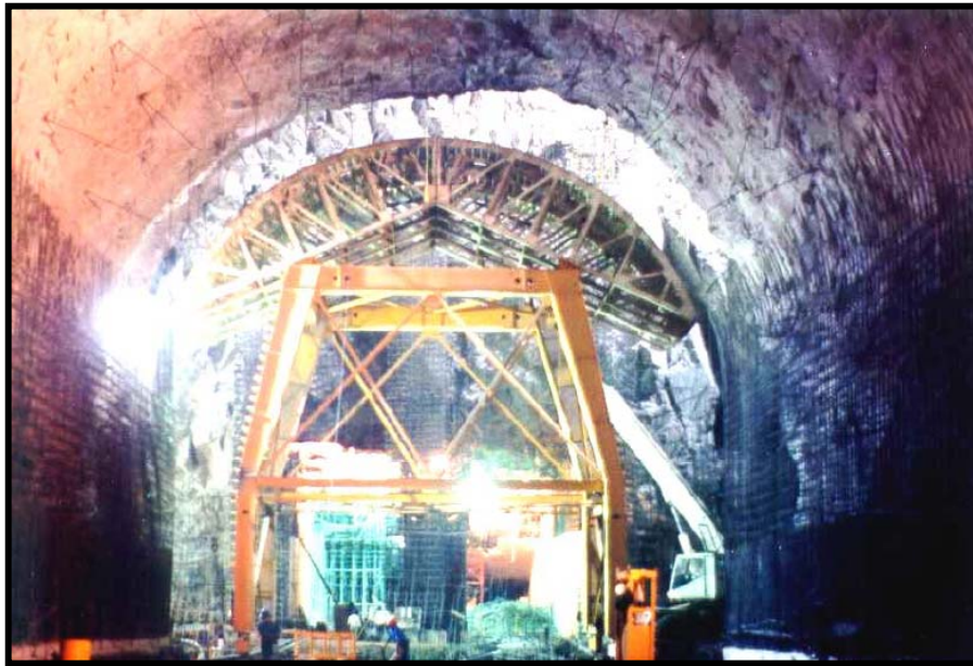
Fig. III.51.-Montaje de piezas centrales para colado de la clave del túnel
