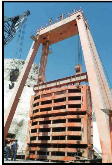
Fig.III.93.-Proceso de armado en sitio de la compuerta de cierre final
