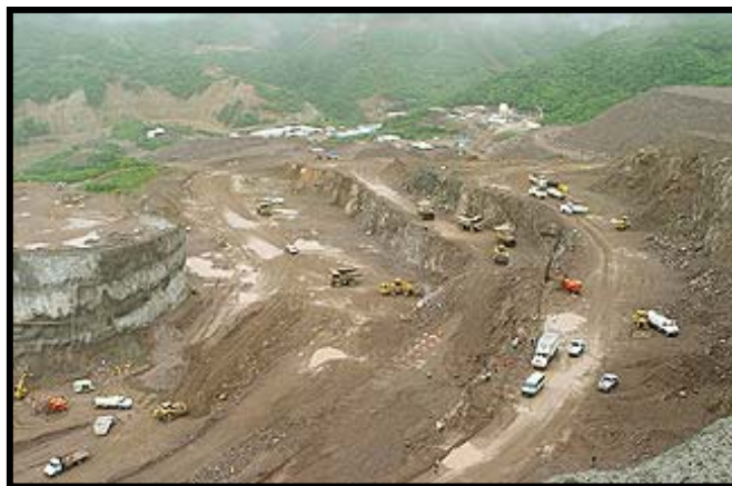
Fig.III.72.-Excavación canal de descarga
