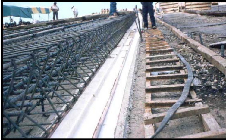
Fig.II.26.-Junta vertical tipo 4 lateral de la cara de concreto de la cortina. Nótase la protección con PVC moldeados al sello de cobre para proteger la junta durante el tráfico de armados y cimbrado de la losa adyacente
