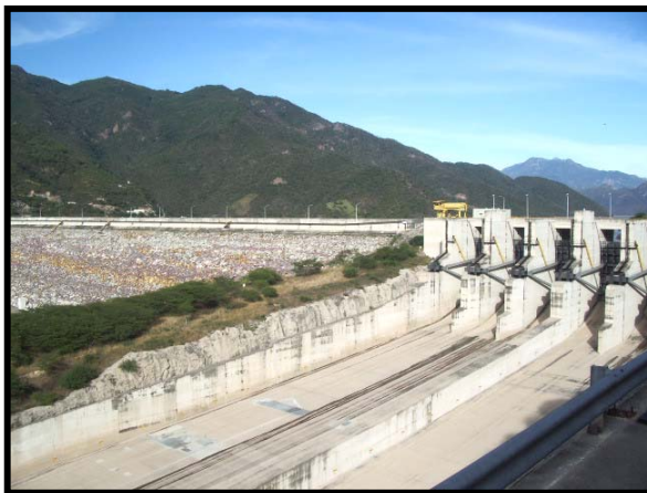
Fig.III.55.-Obra de Excedencias, C.H. Aguamilpa, Nayarit
