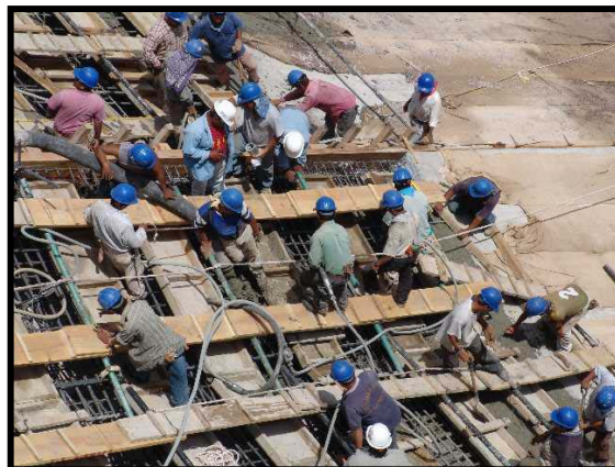
Fig.II.22.-Vaciado de concreto sobre canalones en el colado de la cortina
