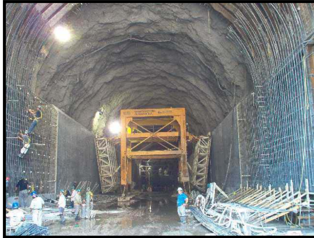
Fig.III.9.-Excavación Túnel de desvío. Nótese el concreto hidráulico aplicado
