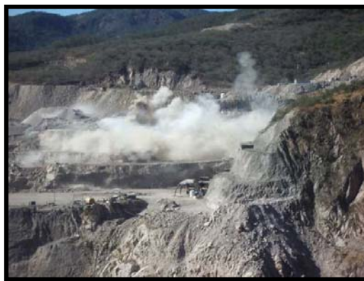
Fig.B-3. Voladura en la zona de estructura de control
