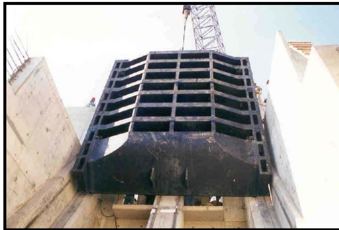
Fig.III.97.-Proceso de montaje de compuerta de servicio sobre viguetas móviles
