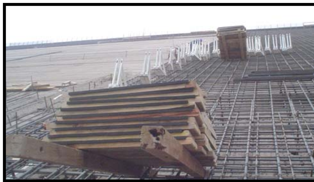
Fig.II.19.- Cimbra de madera
