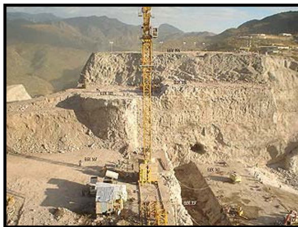
Fig.III.67.-Galería de drenaje e inspección en el cimacio
