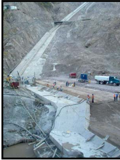
Fig.II.12.-Plinto Margen Derecha visto de frente
