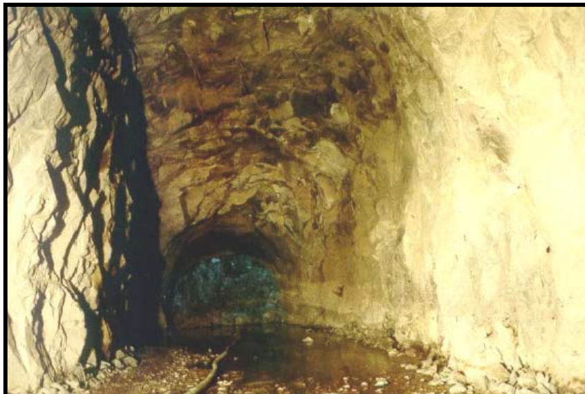
Fig.III.82.-Excavación túnel piloto de aspiración. Al fondo se observa el foso de una de las unidades en casa de máquinas
