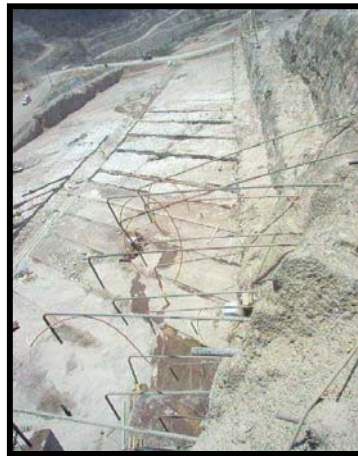
Fig.II.7.- Vista del plinto anclado y colado
