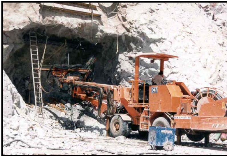
Fig.III.35.- Proceso inicial de excavación de las bocatomas
