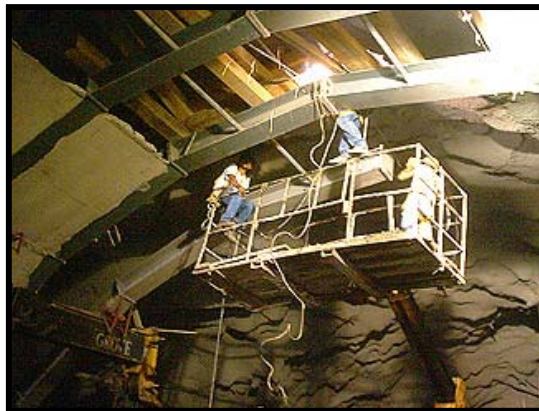
Fig.III.6.- Vista de túnel con marcos metálicos de soporte
