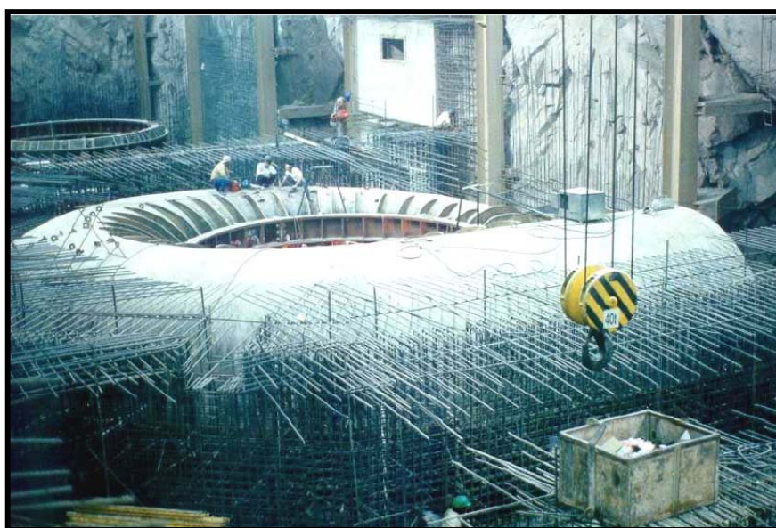
Fig.III.92.-Proceso de revestimiento con concreto armado de la carcasa del Generador
