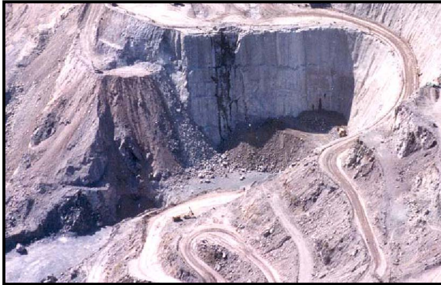
Fig. III.27.-Excavación de la obra de toma
