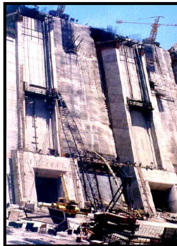
Fig.III.31.-Revestimiento en bocatomas y torres de compuertas
