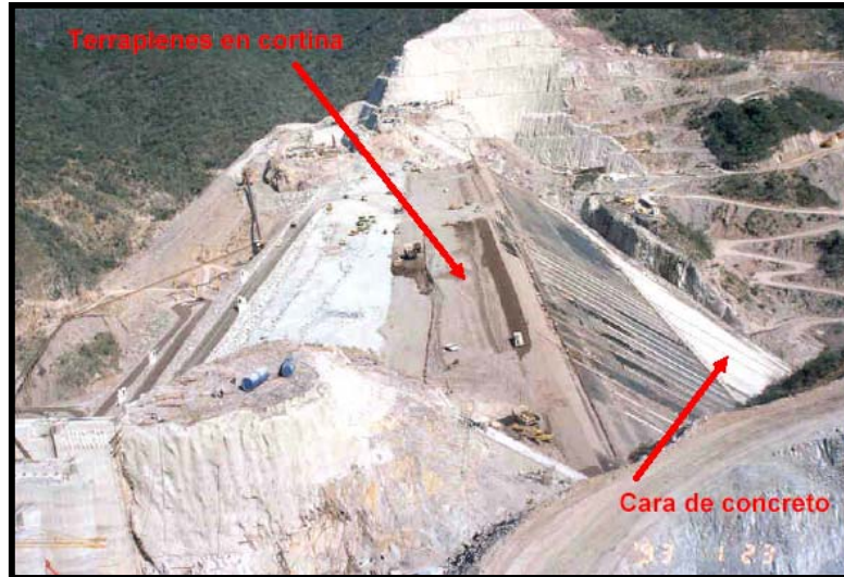
Fig.II.14.-Formación de terraplenes en la cortina. Nótese el proceso de construcción de la cara de concreto de forma simultánea
