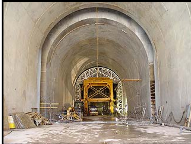
Fig.III.10.-Túnel 1 Obra de Desvío terminado
