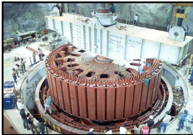
Fig.III.108.-Colocación del rotor dentro del foso
