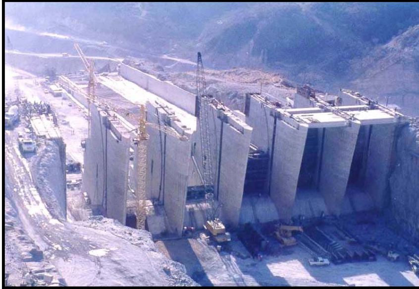
Fig.III.69.-Proceso de revestimiento con concreto en estructura de control
