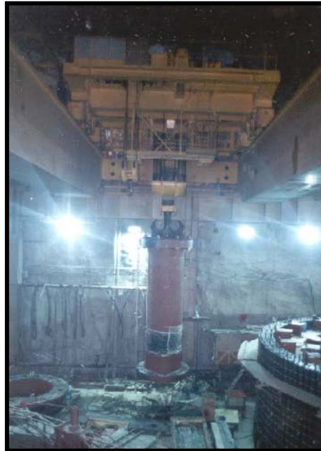
Fig.III.101.-Montaje de flecha en una unidad de casa de máquinas, con apoyo de la grúa viajera
