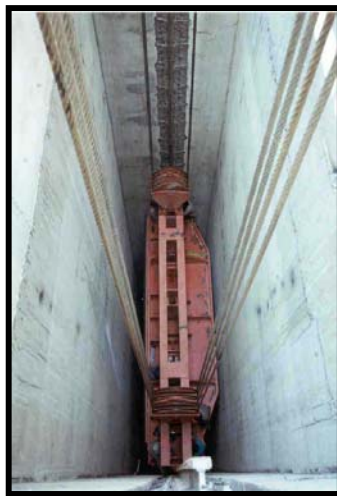
Fig.III.94.-Deslizamiento de la compuerta de cierre final
