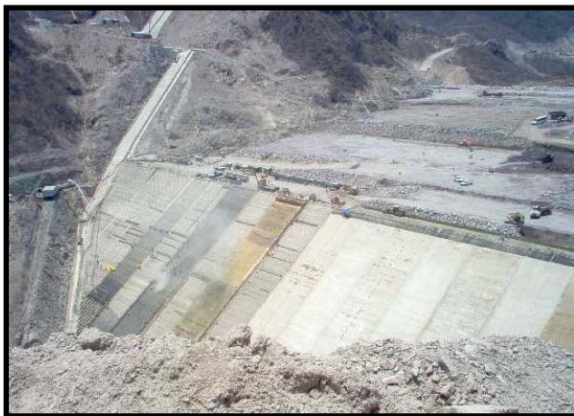
Fig.II.23.-Cara de concreto de la cortina
