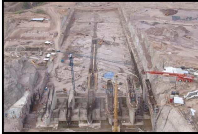
Fig.III.68.-Vista de colocación de concreto en Estructura de control
