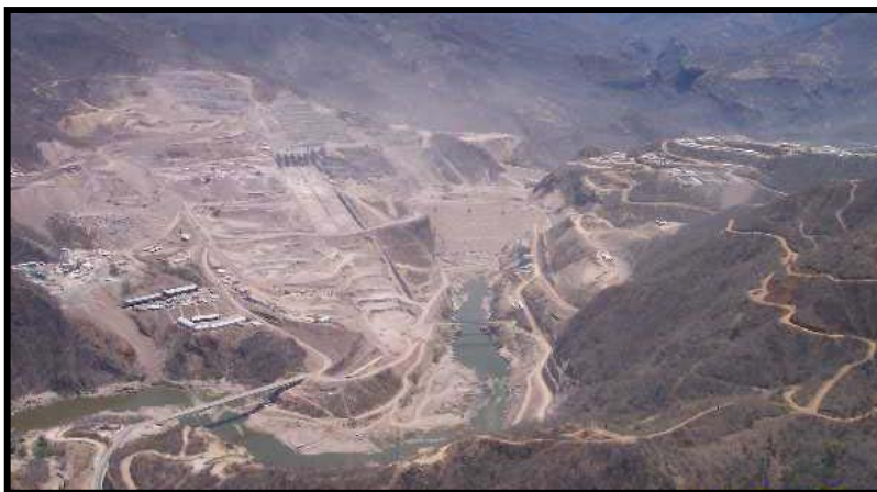
Fig.I.16.- Vista aérea de la zona de obras del PH El Cajón al 6 de abril 2005
