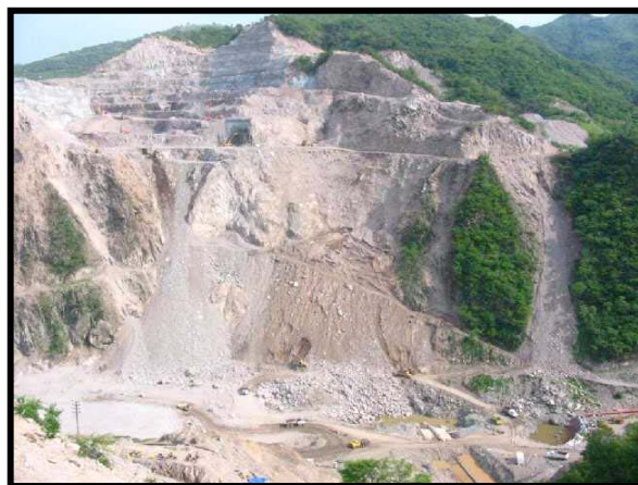
Fig.III.58.-Excavación canal de llamada
