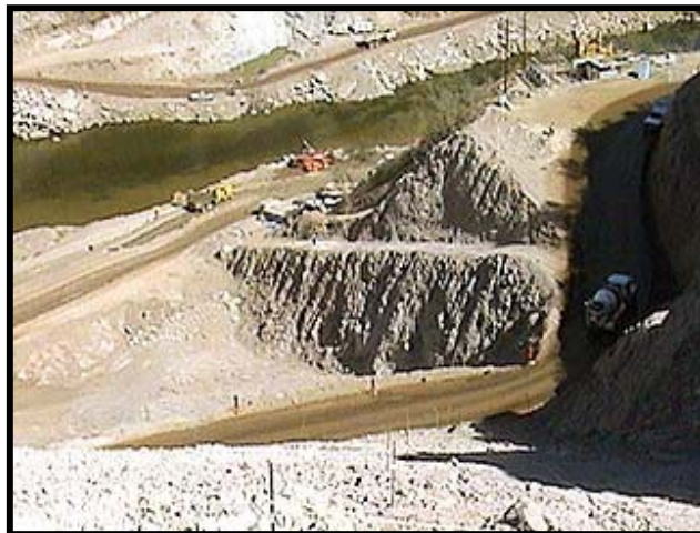
Fig.II.5.- Excavación del plinto margen izquierda
