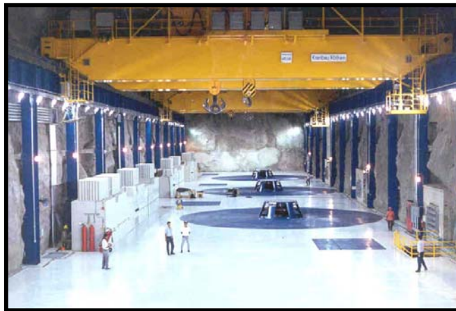
Fig. III.110.-Vista general de casa de máquinas
