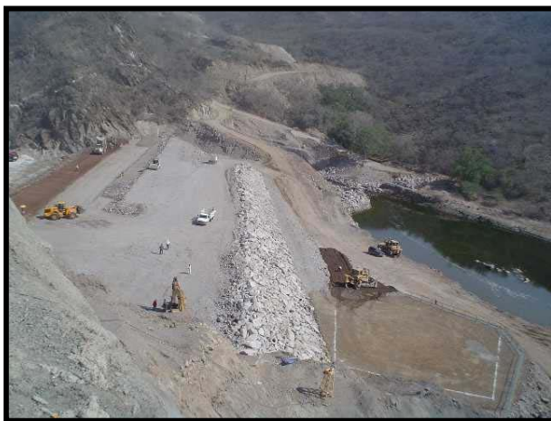
Fig.III.20.-Construcción de la ataguía aguas abajo, Nótese el material impermeable
