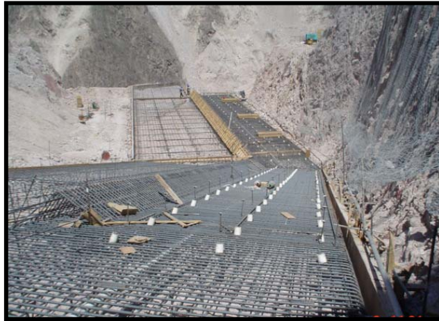
Fig.II.8.-Armado del plinto
