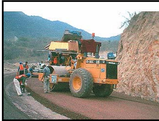
Fig.I.21.- Camino de acceso definitivo en etapa constructiva final
