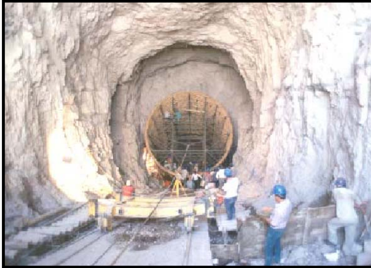
Fig. III.43.-Colocación de cimbra para el colado del codo de la tubería a presión
