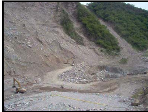
Fig.B-1. Zona en proceso de despálme
