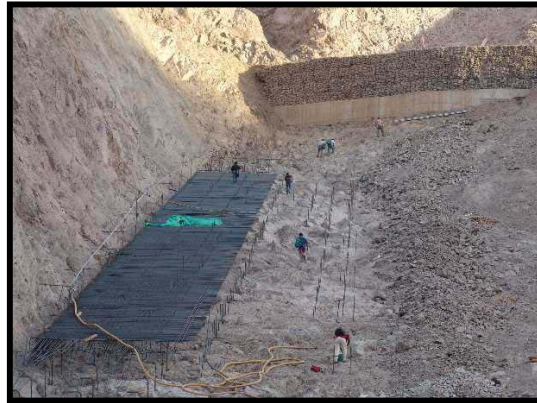
Fig.II.6.- Colocación de anclas en el plinto
