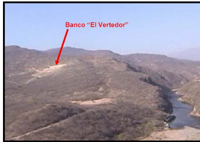
Fig.B-8. Panorámica del banco “El Vertedor”
