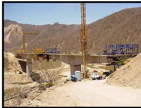
Fig.I.19.- Construcción del Puente Santiago sobre el río Santiago
