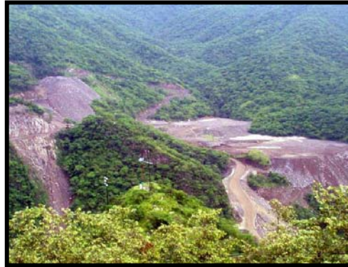
Fig.I.18.- Camino de acceso definitivo en etapa constructiva inicial
