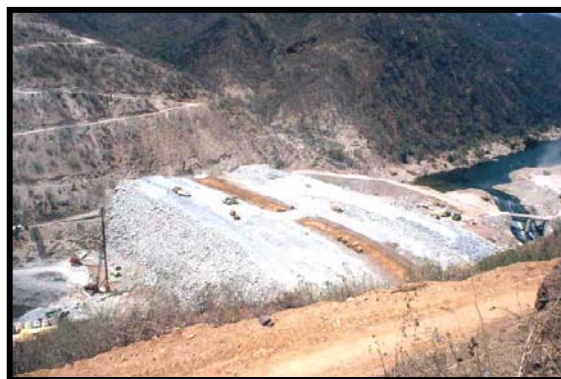
Fig.III.14 Ataguía de aguas arriba en proceso de construcción, formada con materiales graduados y corazón impermeable de arcilla
