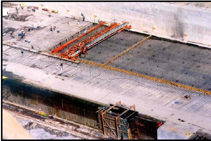
Figura III.73.-Cimbra deslizante en los concretos en zona del canal de descarga
