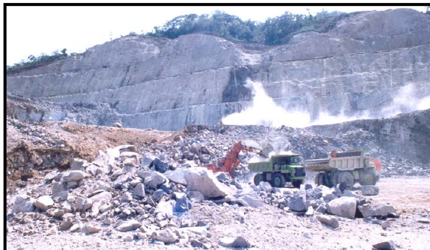
Fig.III.57- Excavación a cielo abierto de las obras de excedencias
