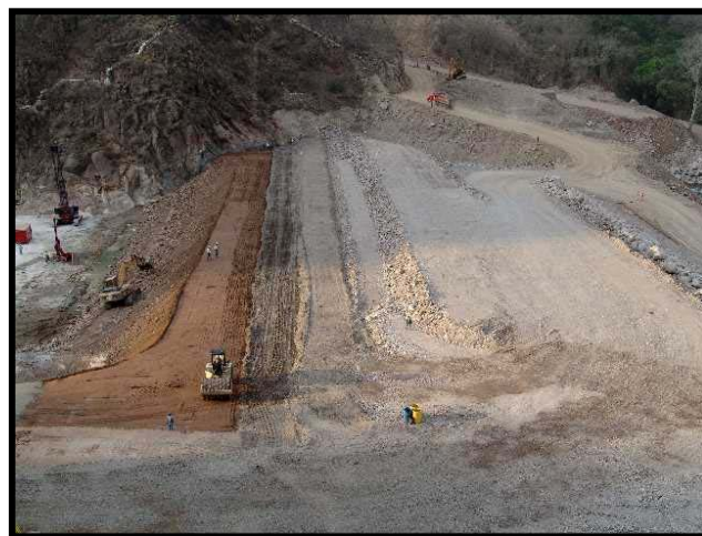
Fig.III.17.- Conformación de la ataguía aguas arriba
