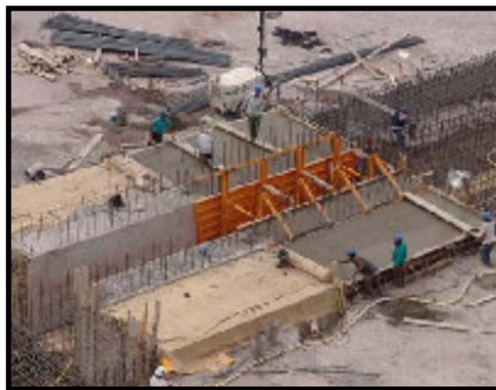
Fig.III.70.-Colado de Galería de Inspección
