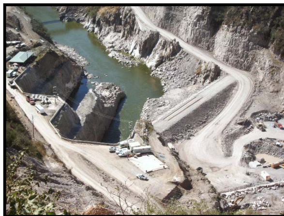
Fig.III.1.-Obra de Desvío El Cajón a Noviembre 2004
