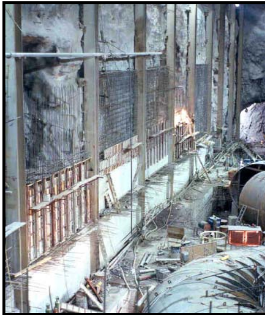
Fig.III.89.-Revestimiento con concreto en paredes laterales de la casa de máquinas
