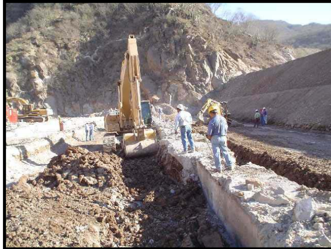
Fig.III.22.-Remoción de material para construir brocales de concreto
