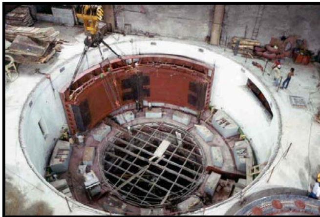
Fig.III.107.-Colocación del segundo sector del estator dentro del foso
