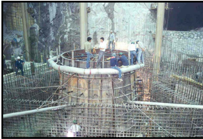
Fig.III.103.-Vista de los conos superior e inferior del tubo de aspiración
