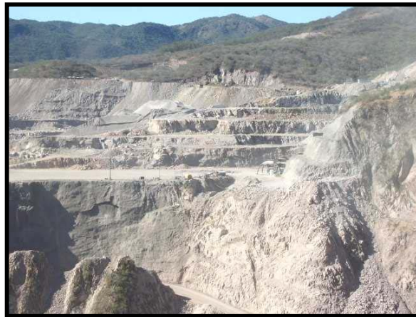
Fig.III.62.-Formación de plataformas, Obras de Control
