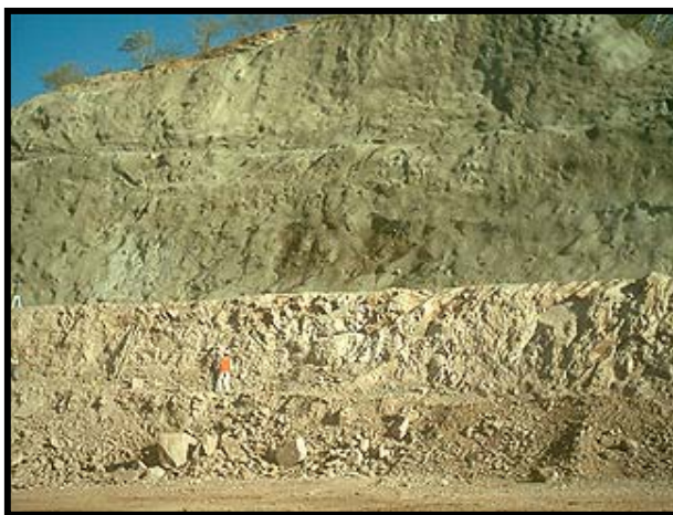
Fig.III.65.-Anclaje en talud canal de llamada. Nótese la capa de concreto lanzado
