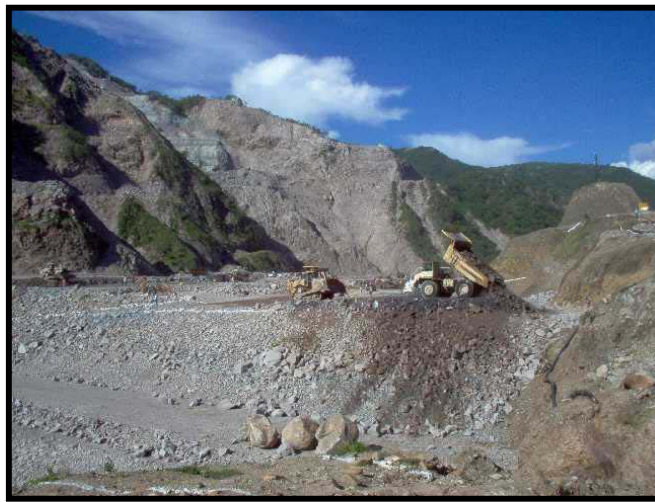
Fig.III.15.- Colocación de material para ataguía
