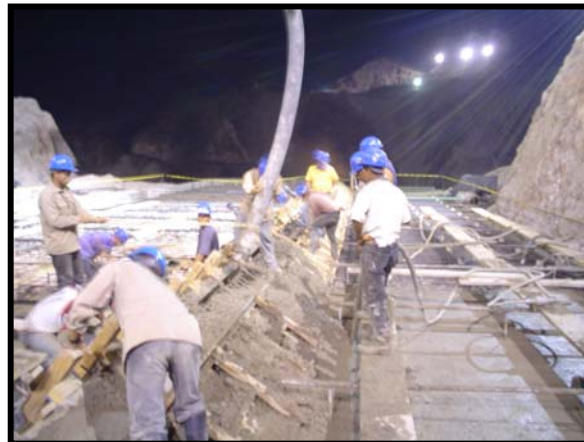
Fig.II.11.-Primer colado del plinto en tramo recto
