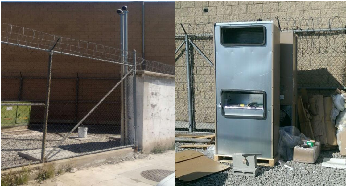
Imagen 3.21 Construcción del gabinete en sitio
