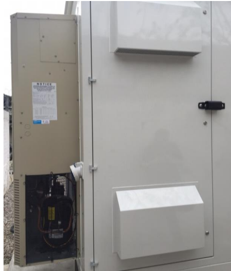
Imagen 3.11 Sistema de ventilación Propuesta A
