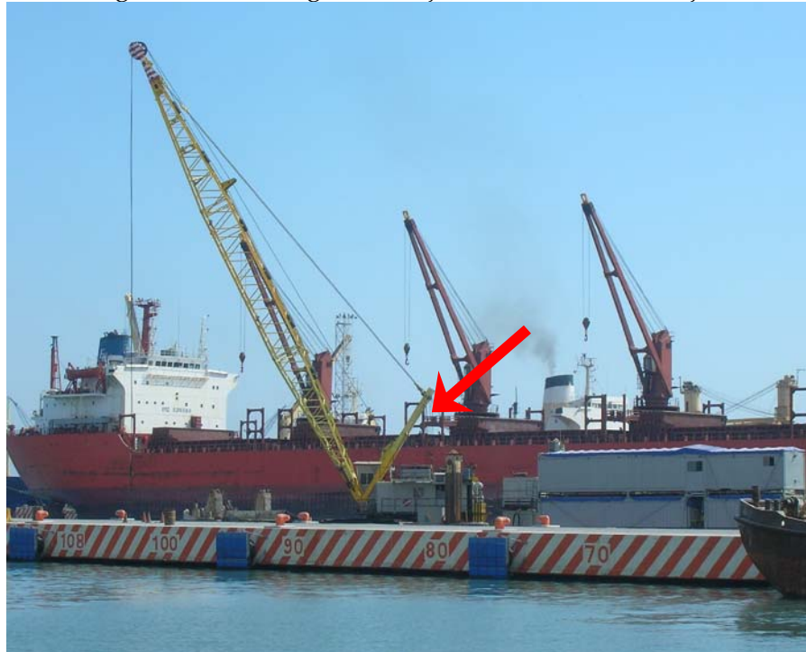
Figura 6.4. Dragas de almeja utilizada en los trabajos.
