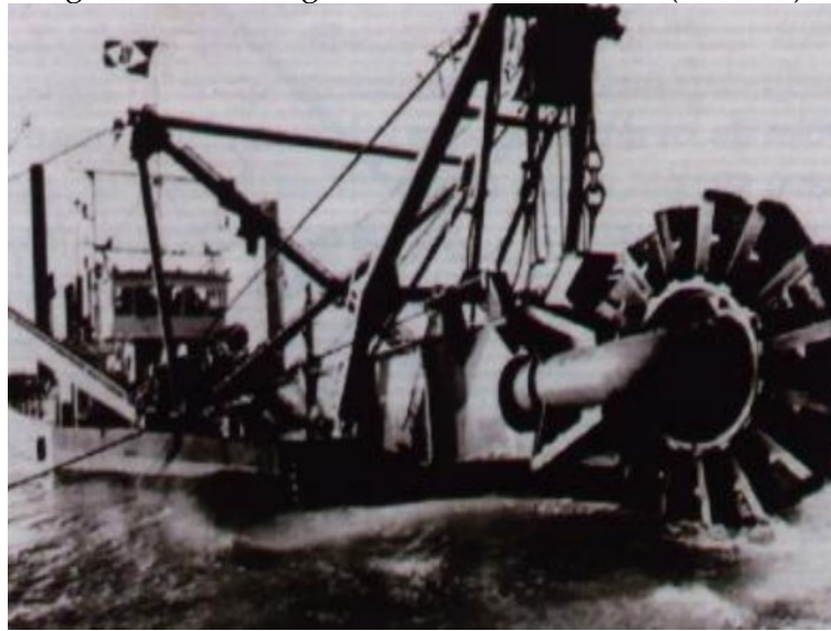
Figura 1.5. Draga de cortador de ruedas ("cutter").
