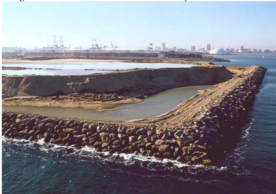
Figura 5.11. Punto de vertido construido y en funcionamiento.
