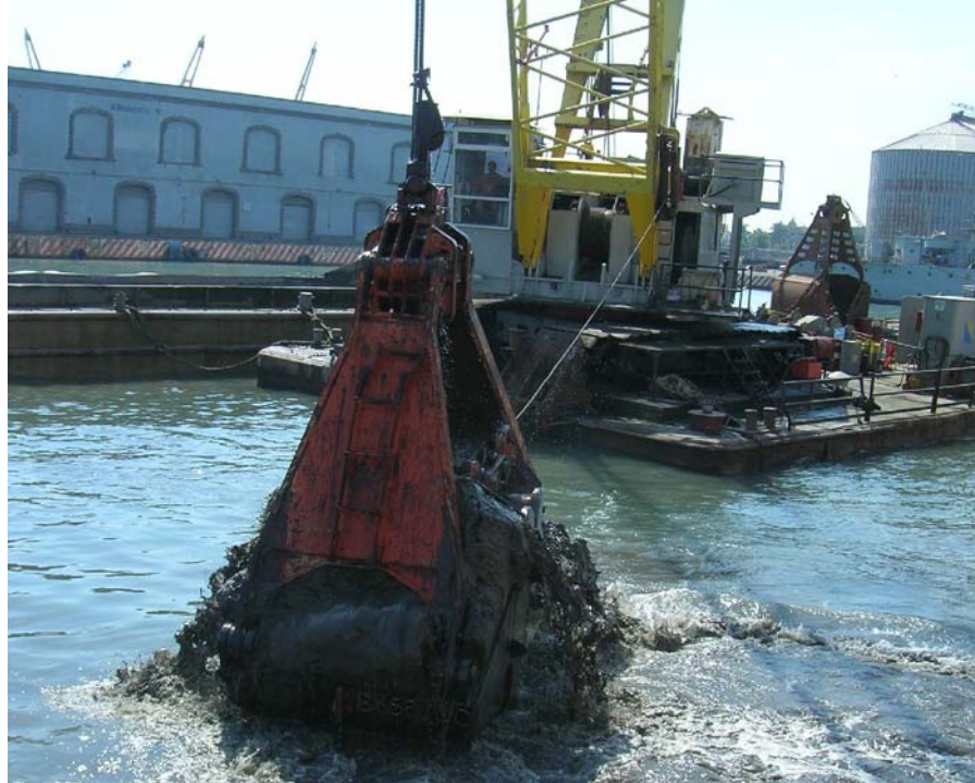
Figura 6.3. Draga de almeja utilizada en los trabajos.
