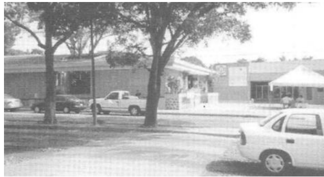
Figura 2.21 Vista general de la clínica-hospital "Dr. Miguel Trejo Ochoa"
