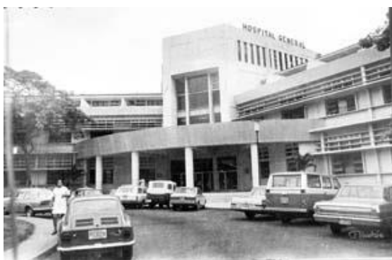
Figura 2.52 Hospital general de Managua “El Retiro” (antes del sismo)
