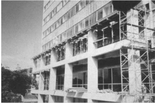
Figura 2.36 Hospital México (Remodelación)
