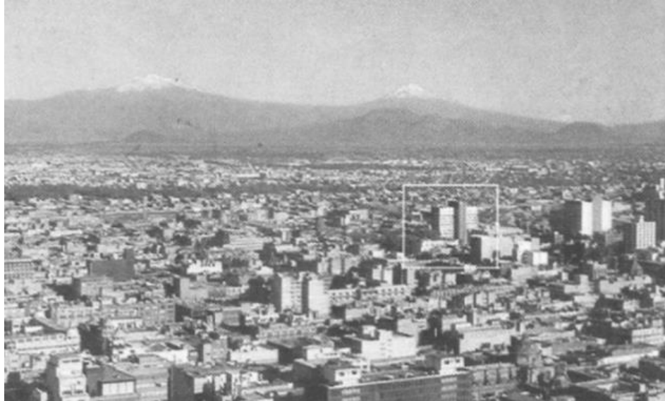
Figura 2.17 Torre de Hospitalización del Hospital Juárez del Centro
