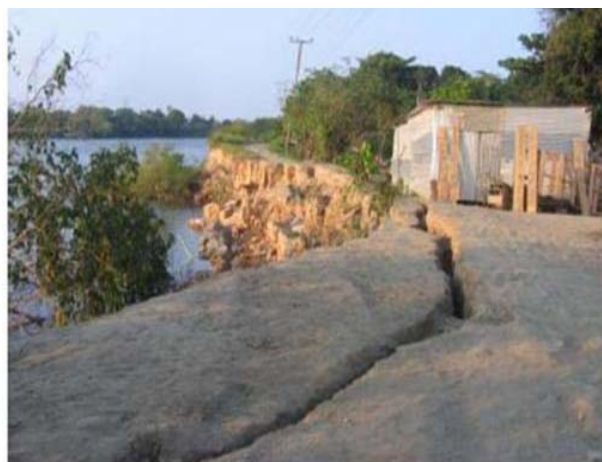
Figura 4.12 inestabilidad favorecida por erosión fluvial (Auvinet et. al. , 2008)
