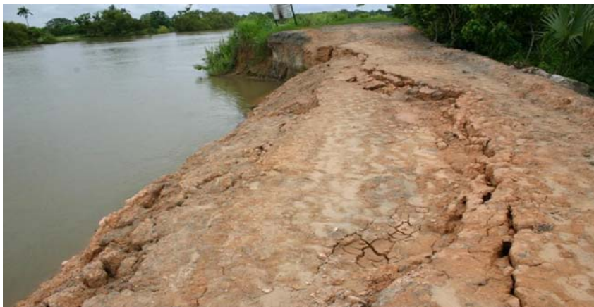
Figura 4.13 Falla de talud favorecida por cortante, favorecida por el peso del bordo. (Auvinet et. al. , 2008)
