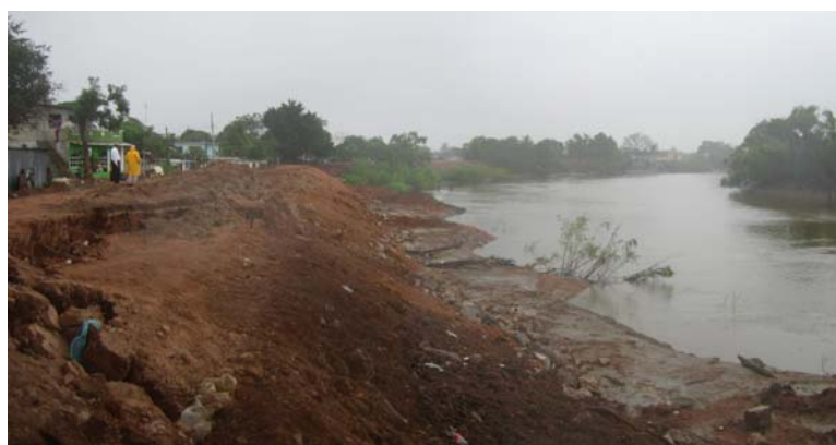
(a) Bordo en la margen
