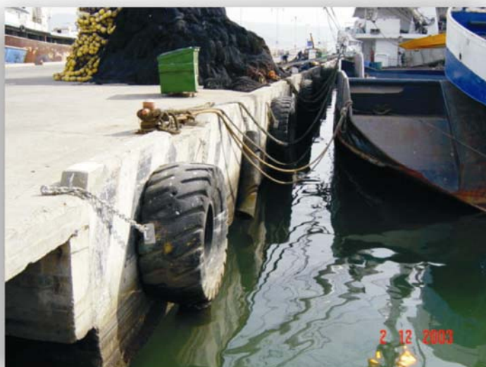
Figura I. 19 Defensas en muelle 240
