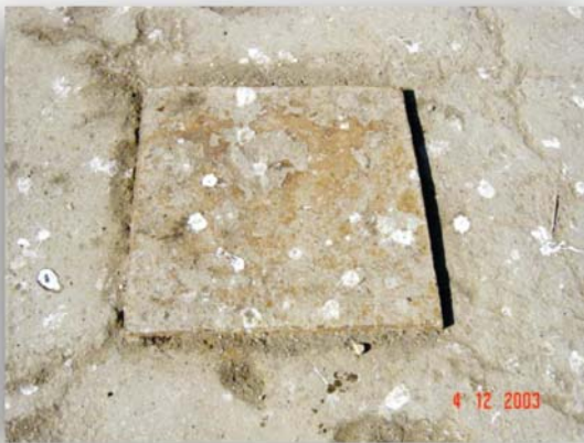
Figura I. 42 Instalación eléctrica en muelle 2
