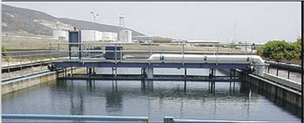
Figura I. 91 Planta de Tratamiento El Sauzal
