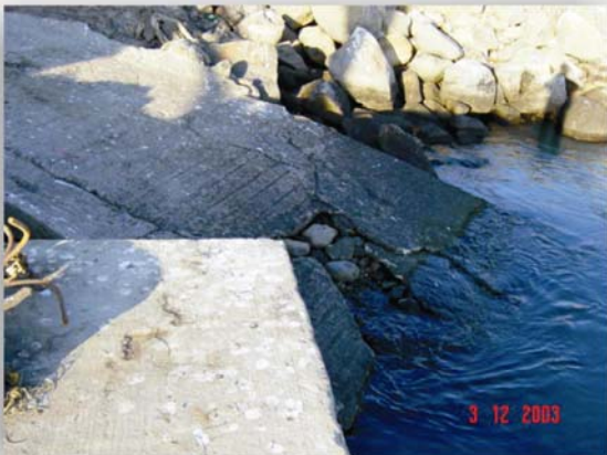
Figura I. 49 Rampa de embarcaciones ribereñas
