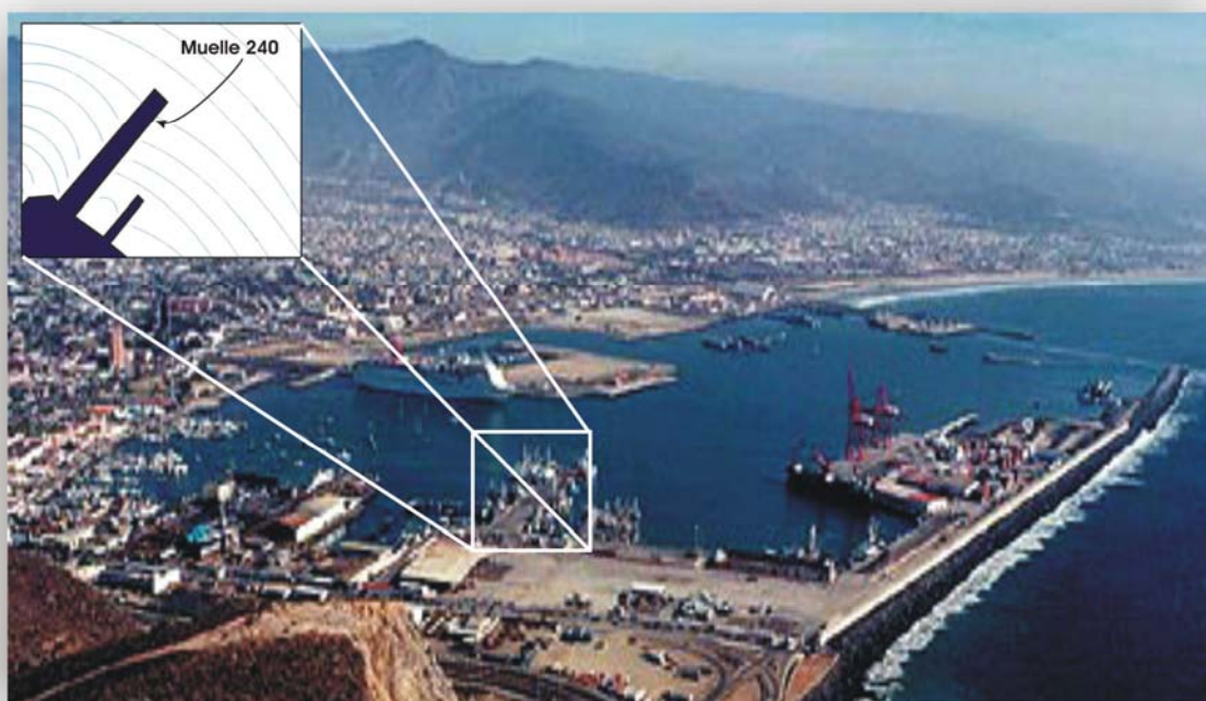
Figura I. 11 Muelle 240. Puerto de Ensenada
