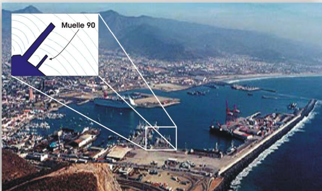
Figura I. 2 Muelle 90 Puerto de Ensenada
