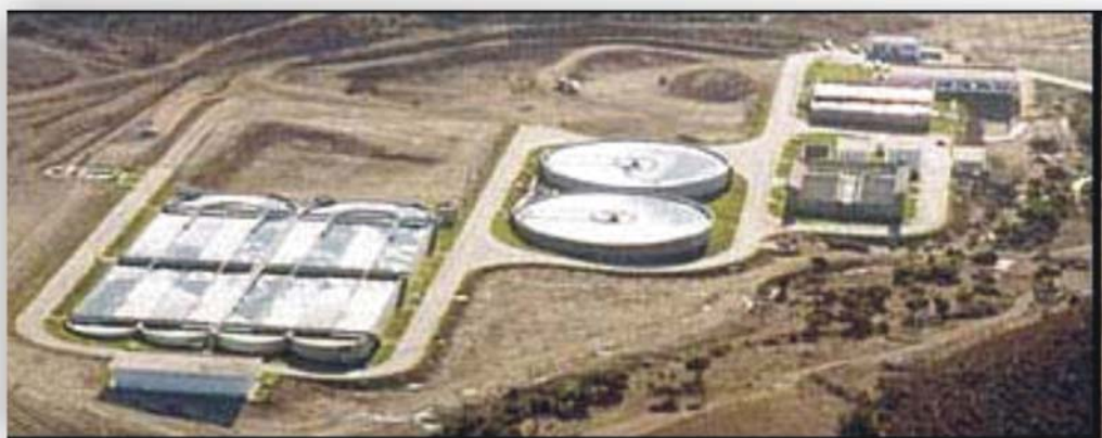
Figura I. 88 Planta de Tratamiento El Naranjo
