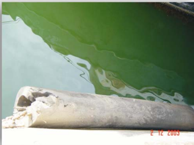
Figura I. 8 Defensas originales en muelle 90
