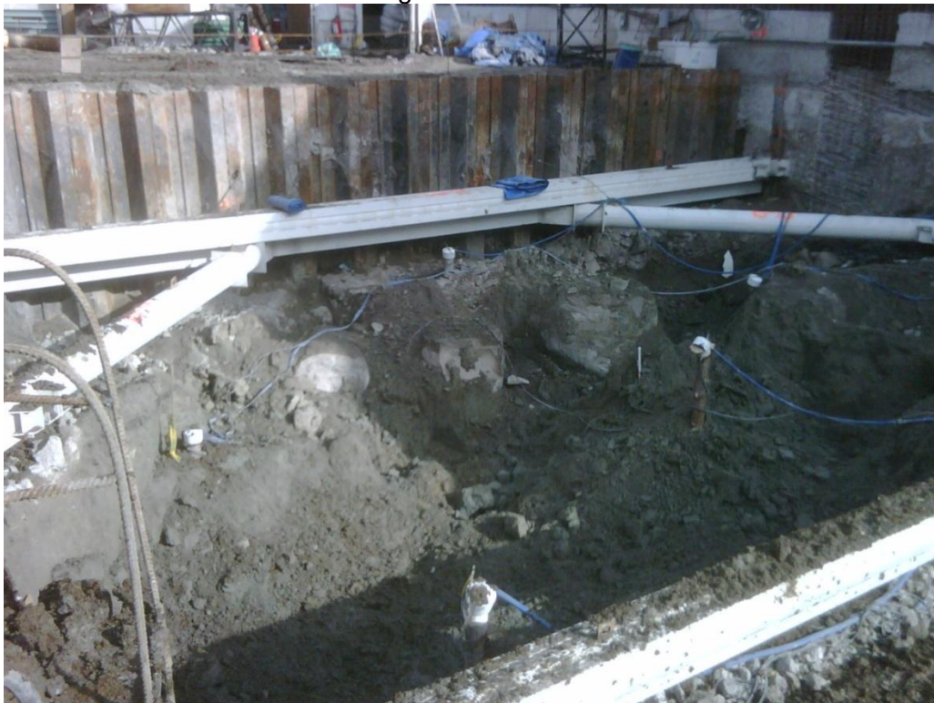
Fig. Tablestaca auxiliar, troquelamiento, descubrimiento de pilas, pozos de observación.
