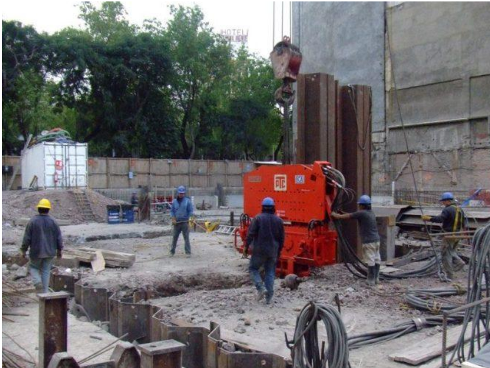
Fig. Instalación de tablestaca auxiliar.
