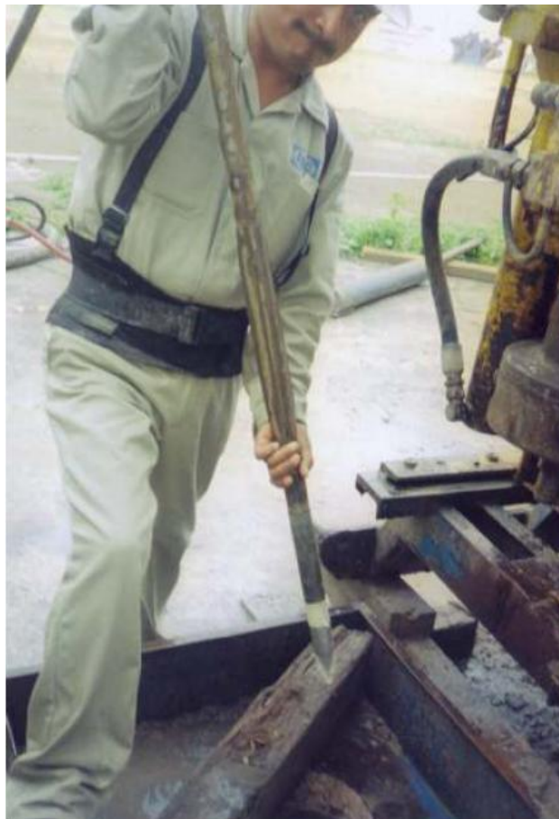
Fig. Aspectos de la realización del sondeo con piezocono.
