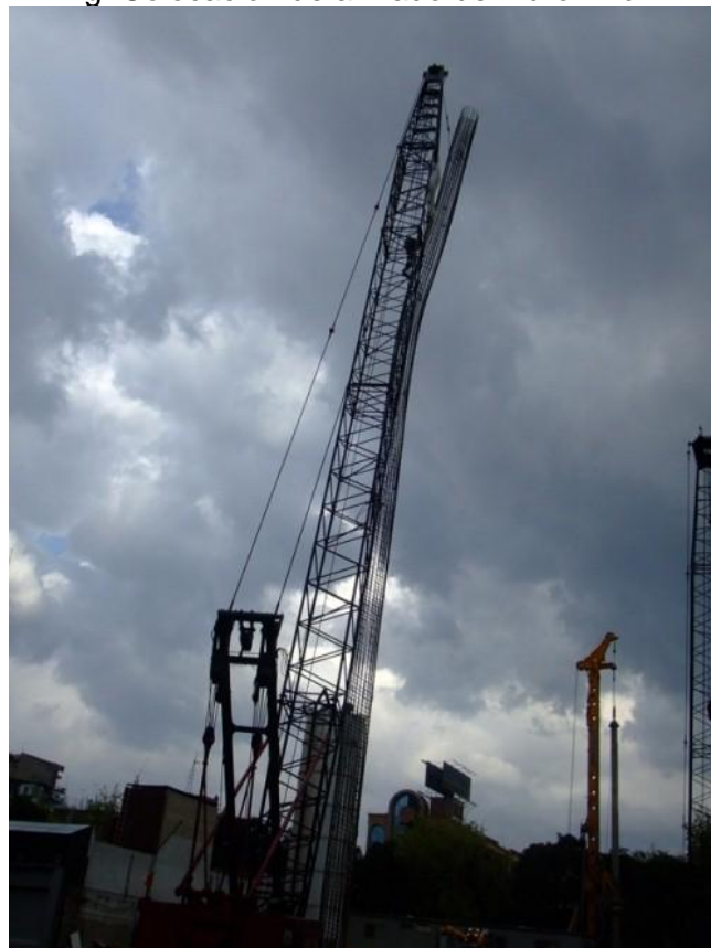
Fig. Colocación de armado de pilas.
