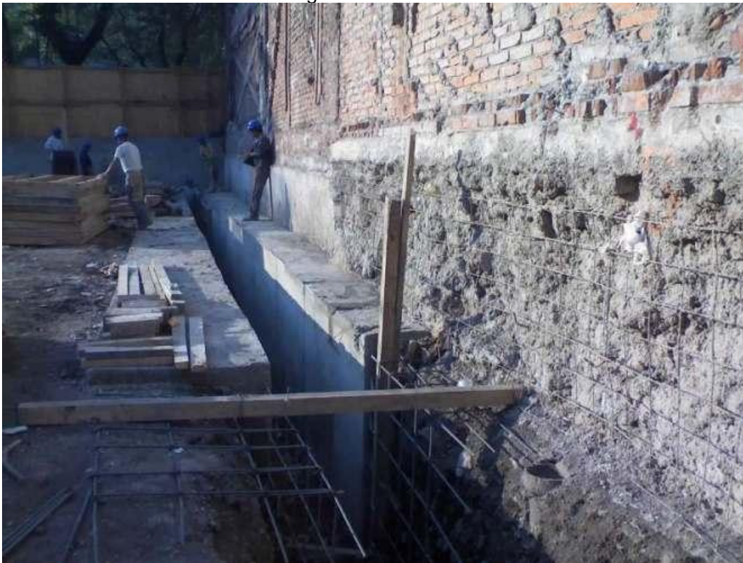
Fig. Construcción de brocal para muro Milán.
