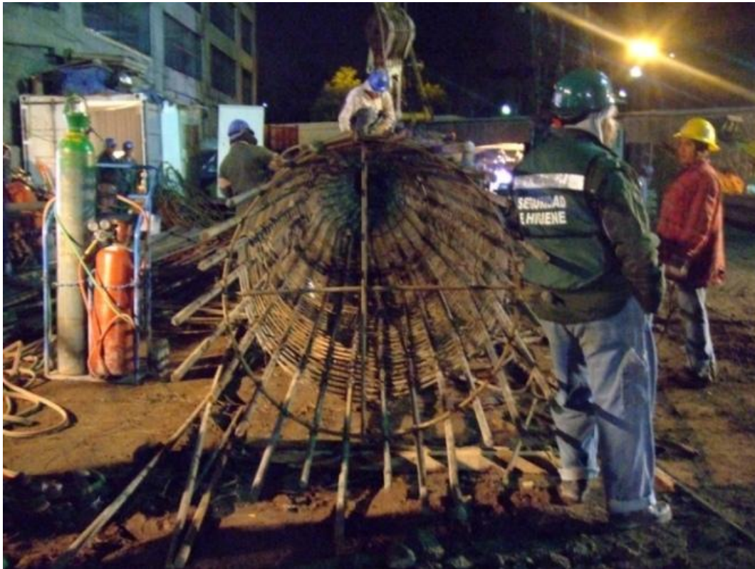
Fig. Armado de pilas.
