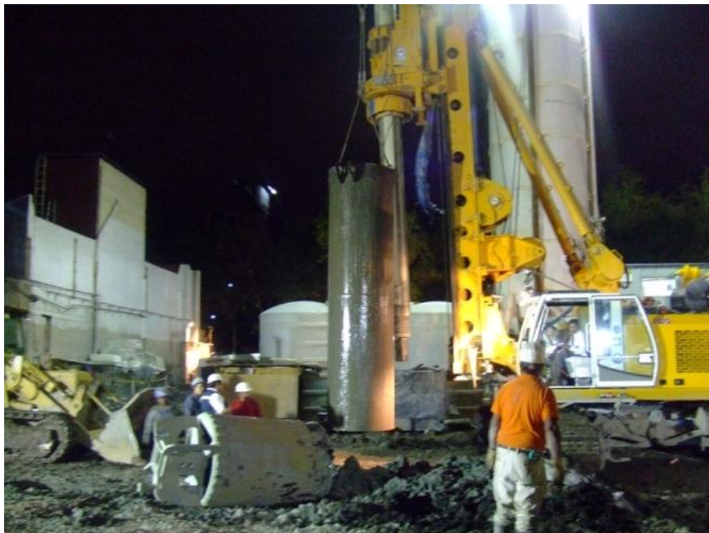
Fig. Excavación de pilas.
