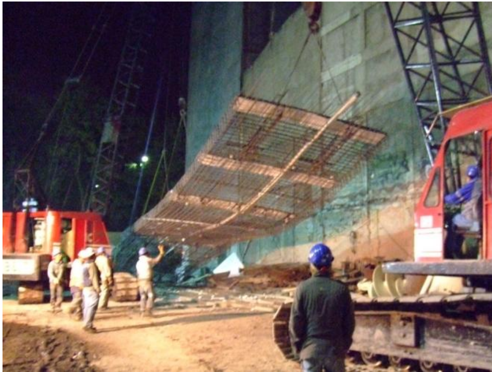
Fig. Colocación de armado de muro Milán.
