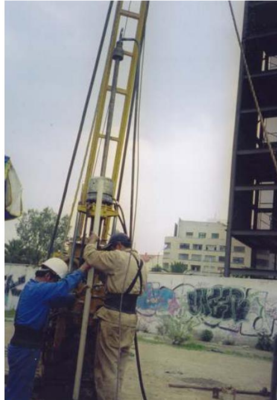
Fig. Instalación del tubo de observación del nivel freático.
