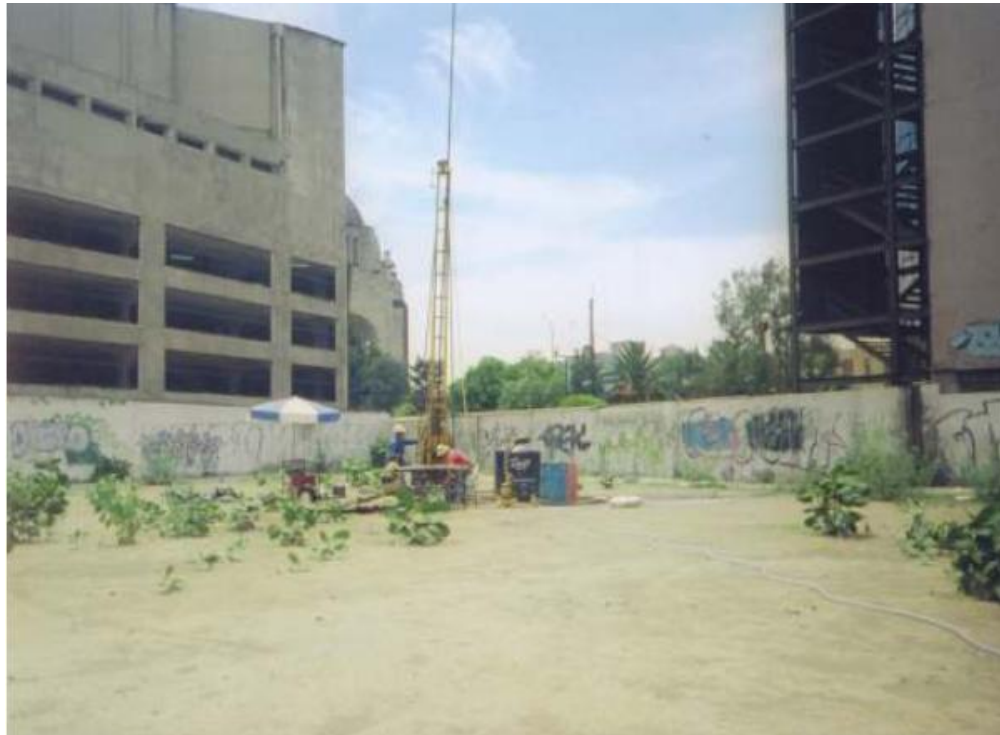
Fig. Ejecución del sondeo SE -1
