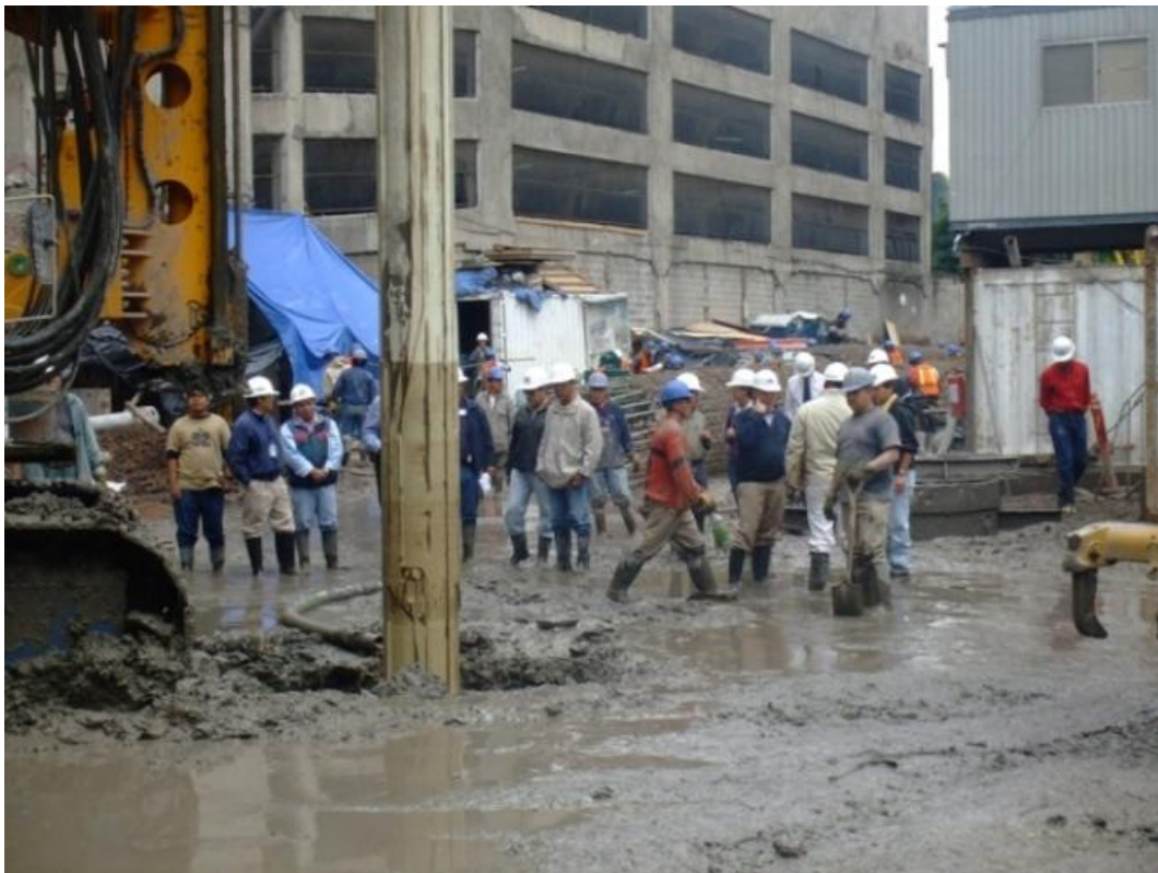
Fig. Colado de pilas.
