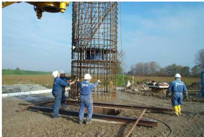
Figura 3.9 “Acero de Refuerzo de un Pila”
