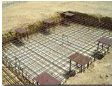
Figura 3.8 "Losa de Cimentación"
