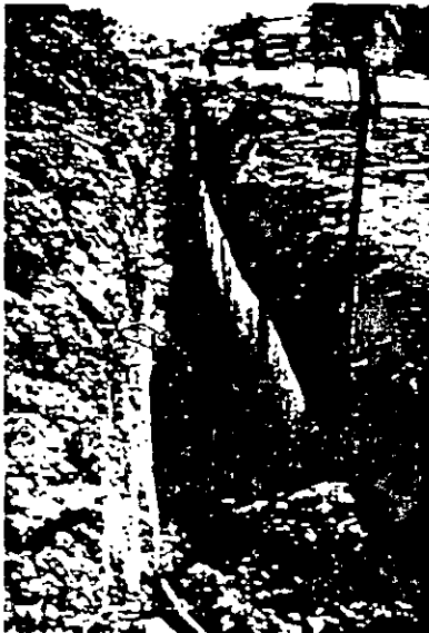
Subdrén geocompuesto prefabricado colocado en la zanja.
