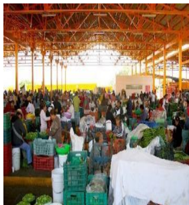
Vista panorámica nave C
