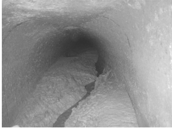
Figura 2.1. Desfogue de fondo con sedimento, Presa Cubillas (González de la Aleja)
