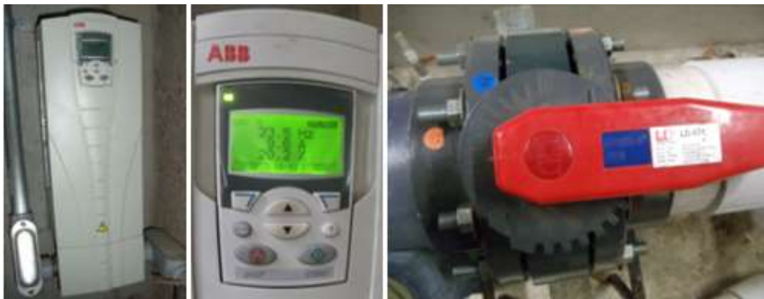
Figura 4.4. Dispositivo variador de velocidad de giro de la bomba y válvula de mariposa de 20 cm (8 in)
