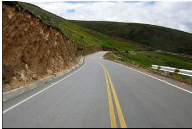
Figura 3.8 Camino Pavimentado. Fuente: SCT, Subsecretaría de Infraestructura.
