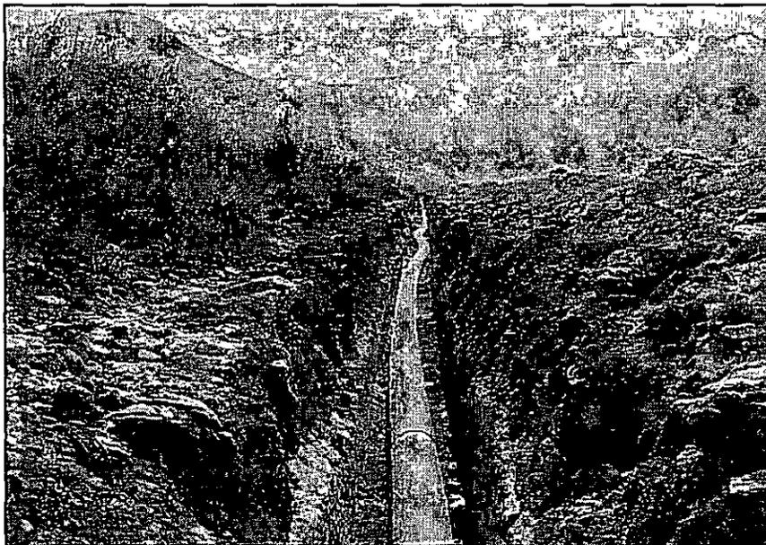
FIGURA 14. TUBERÍA COLOCADA EN LA ZANJA.
