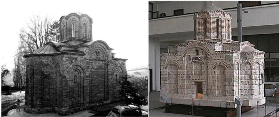
Figura 1.4 Iglesia de St. Nikita. Prototipo y modelo escala 1:2.75 (Shendova, et al., 2012).
