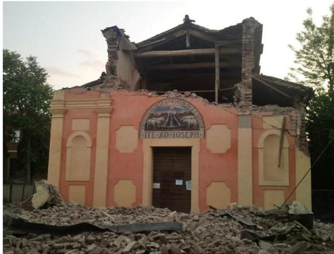
**Figura 2** Falla fuera del plano de la fachada de un templo ubicado en Italia (Tizianok, 2012).
