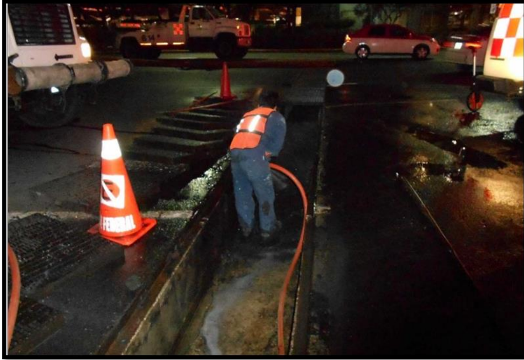
Figura 3.13. Limpieza final de trinchera con agua a alta presión. Fuente: Estimación 5.
