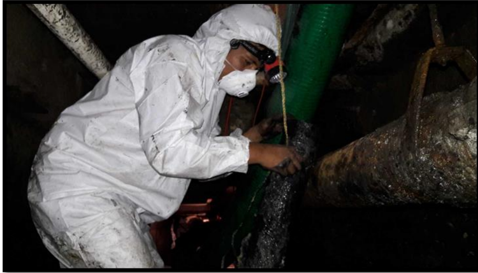
Figura 3.28. Trabajos de limpieza y reparación en trinchera de Banda 8 de equipaje de la Terminal 1. Fuente: Estimación 8.
