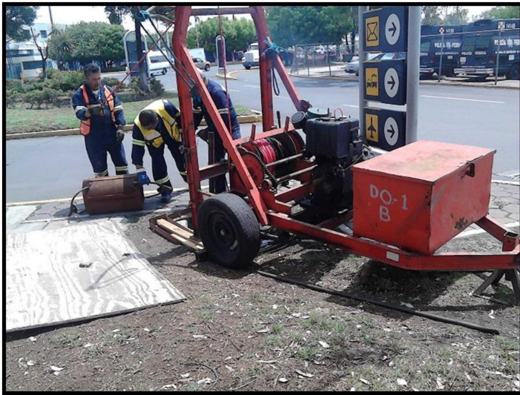
Figura 3.8. Conectando draga de 24" al cable de los malacates. Fuente: Estimación 3.
