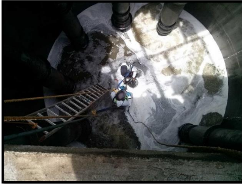
Figura 3.18. Trabajos en Cárcamo 5. Fuente: Estimación 7.
