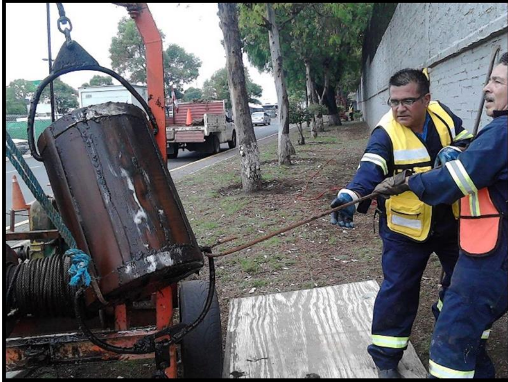
Figura 3.11. Retirando la draga del pozo después de haber recorrido la línea conl azolve. Fuente: Estimación 3.
