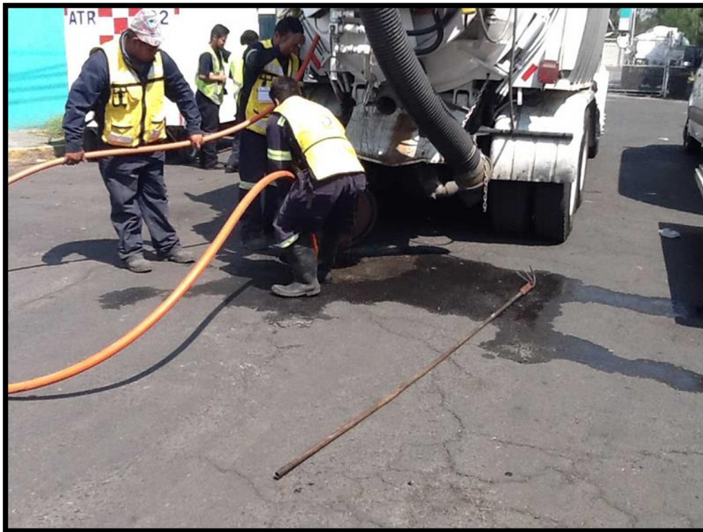
Figura 3.5. Preparación de un pozo de visita previo a limpieza con malacates. Fuente: Estimación 2.
