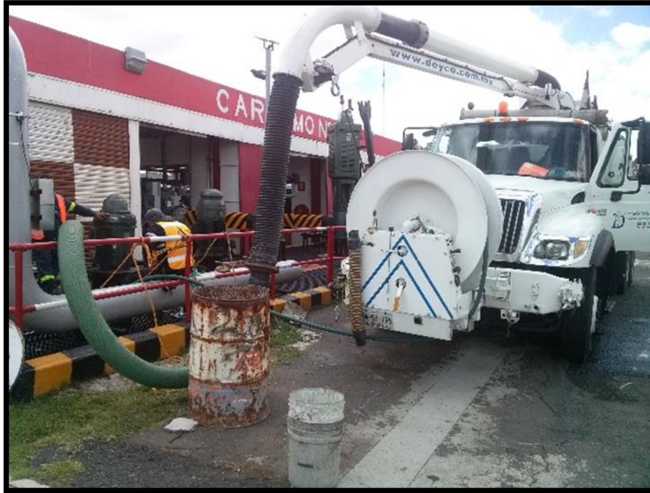
Figura 3.17. Trabajos en Cárcamo 5. Fuente: Estimación 7
