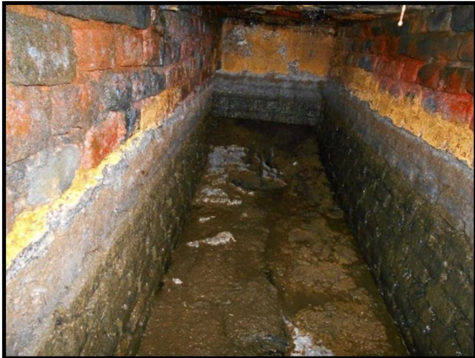
Figura 3.25. Trinchera en Banda 8 de equipaje de la Terminal 1. Fuente: Estimación 8.
