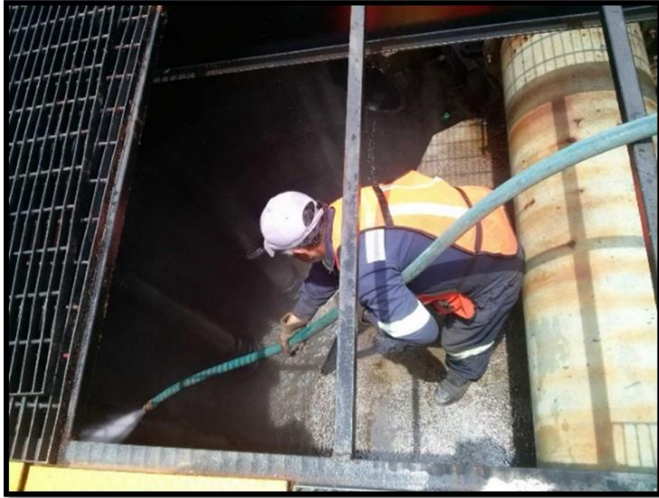
Figura 3.20. Limpieza con manguera de agua a alta presión en cárcamos. Fuente: Estimación 7
