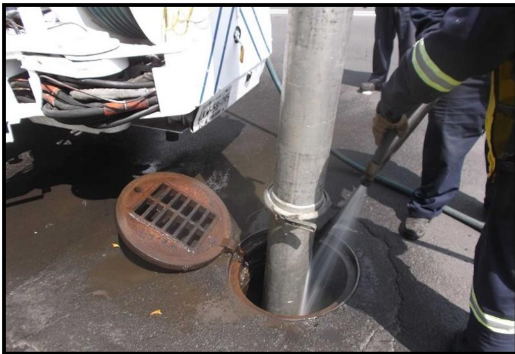
Figura 3.14. Limpieza final de pozo de visita con agua a alta presión. Fuente: Estimación 7.
