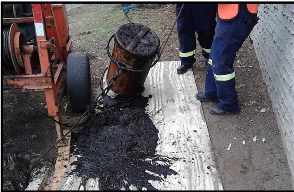
Figura 3.10. Azolve derramado sobre superficie de triplay para facilitar la limpieza del lugar. Fuente: Estimación 3.
