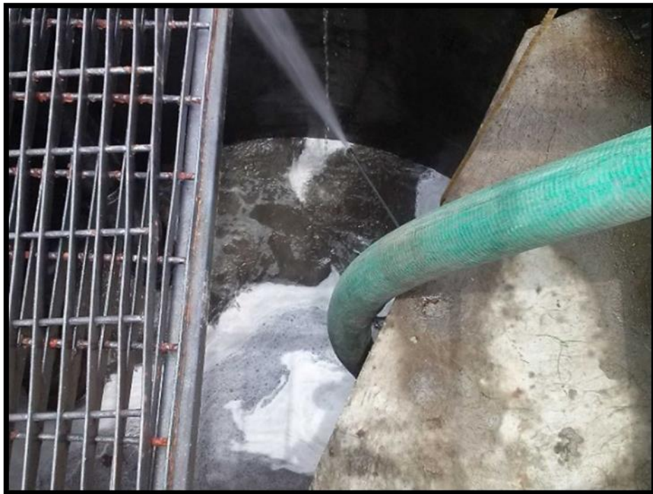
Figura 3.21 Limpieza con manguera de succión en cárcamos. Fuente: Estimación 7
