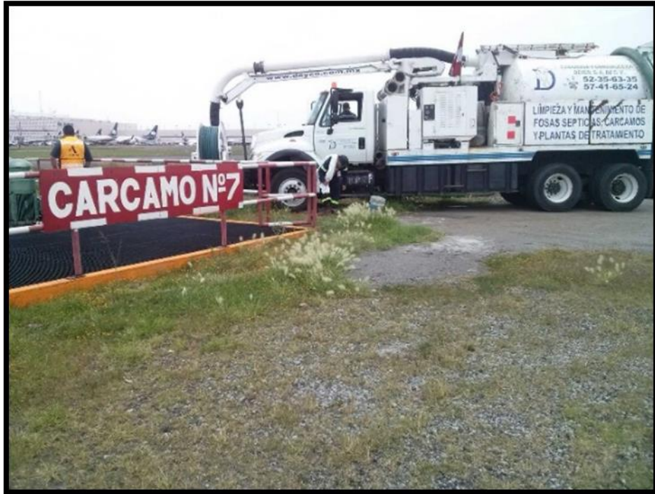
Figura 3.15. Trabajos en Cárcamo 7. Fuente: Estimación: 4
