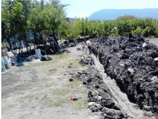
Fig. 5 Ceba en tramo con tránsito vehicular
