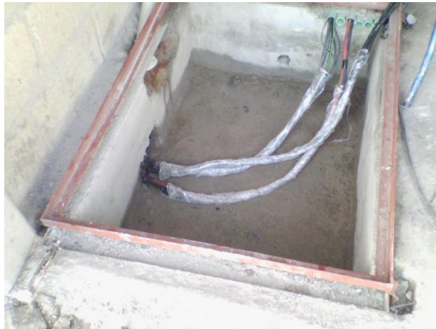
Fig. 10 Trinchera del Centro de Control de Maquinas.
