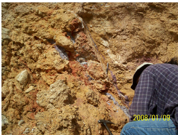
Figura 38. Vista de la oxidación y las vetillas de cuarzo en la Formación San Marcos, al sureste del ejido Las Coloradas.
