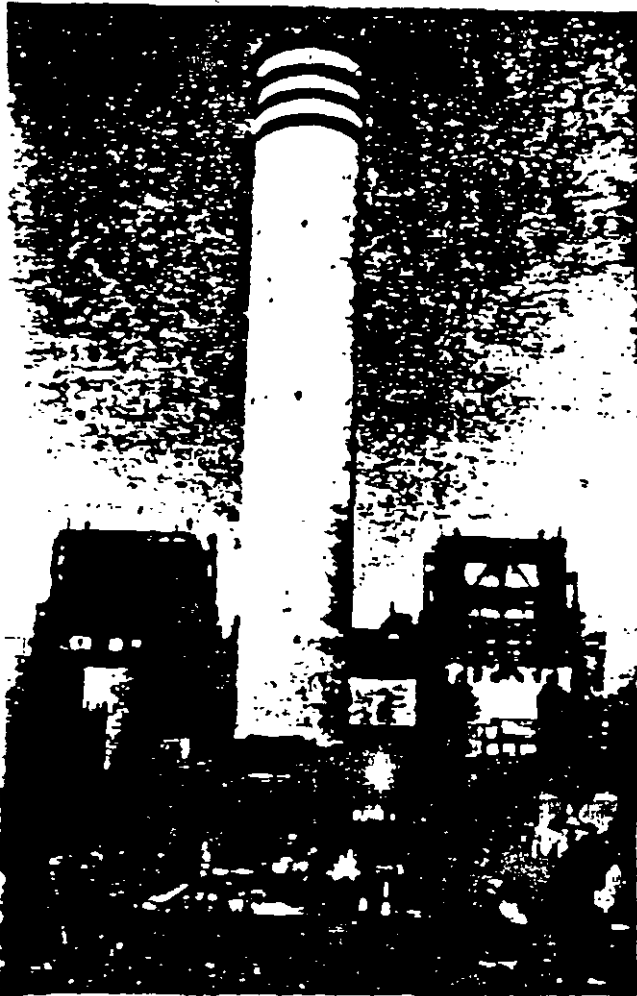
Chimenea Normalizada. Fuste de Concreto alojando dos tiros para dos unidades.
