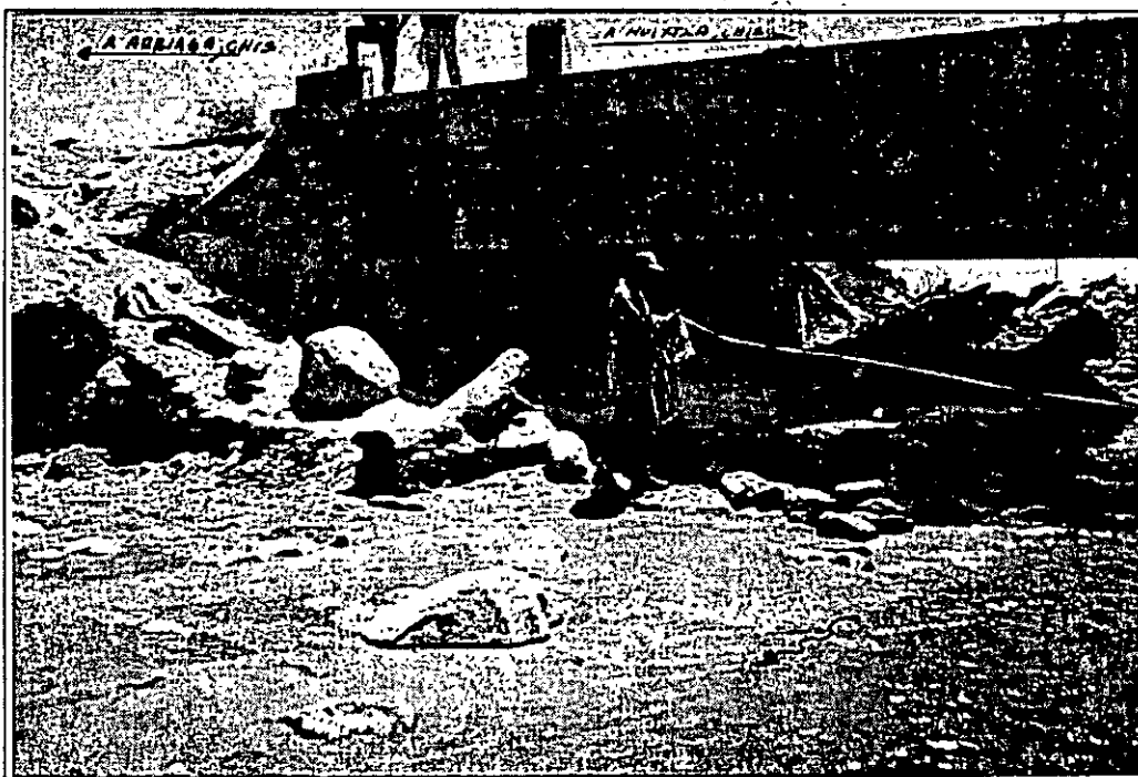
FOTO No.2 PUENTE "BOBO" SOBRE LA CARRETERA FEDERAL, VISTO HACIA AGUAS ABAJO DEL SITIO DE CRUCE. OBSERVESE LA MAGNITUD DE LOS ARRASTRES.
