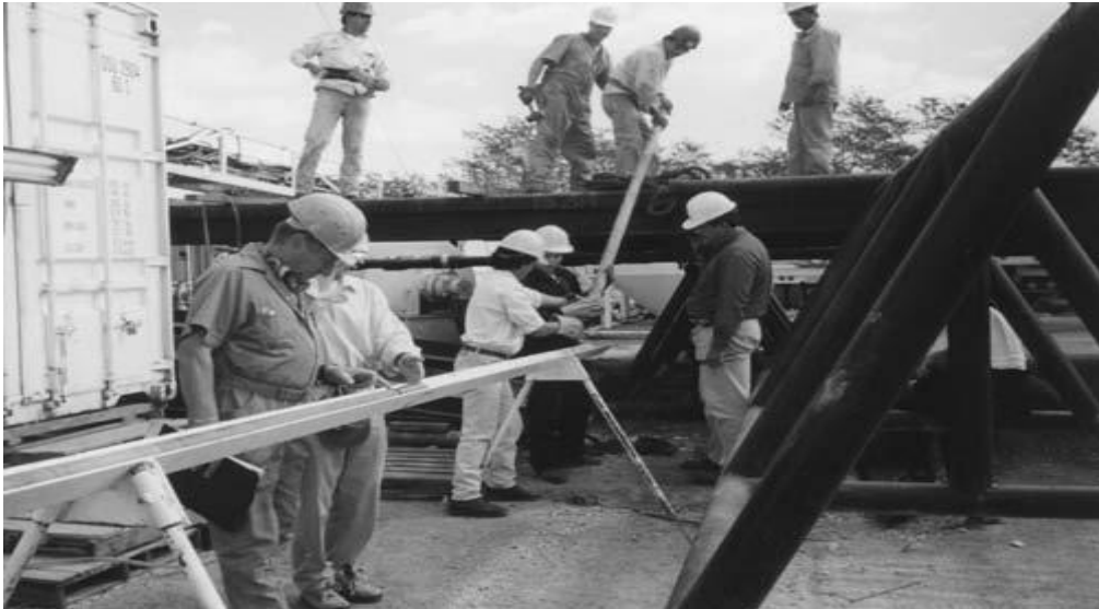
Figura. 2.5. Operaciones de Perforación y núcleo para el Pozo, (Urrutia et al., 2004).
