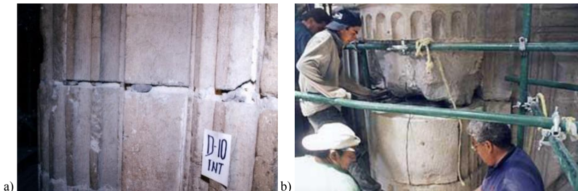
Figura 2.15. Reparaciones en las columnas de Catedral durante el programa de rehabilitación (Meli y Sánchez, 2001): a) eliminación de cuñas de piedra, b) sustitución de sillares
